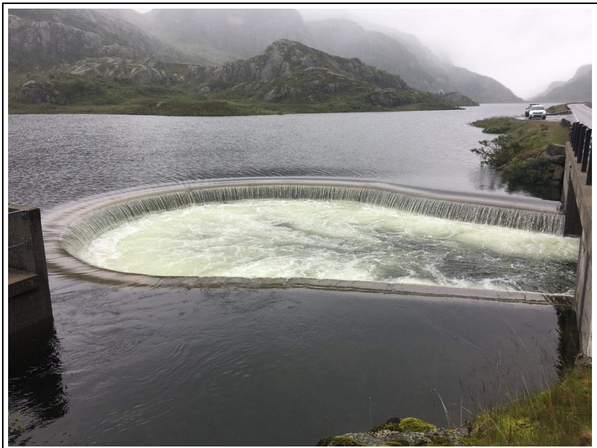
Store snømengder i fjellet vinteren 2020 medførte overløp på en rekke magasiner i fjellet. Her fra dammen på Hunnevatn, øverst i Dirdal/Hunnedalsvassdraget juli 2020 (foto: Mats Grendal).
