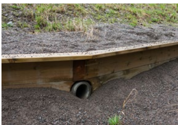
Bilde 9.20. Et salamanderhotell som er bygd inn i en veifylling, Nittedal kommune.
