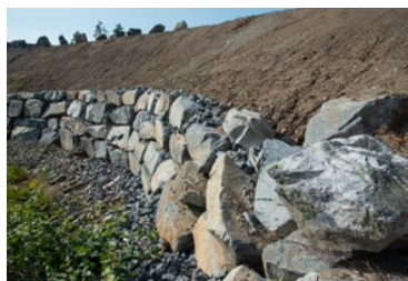
Bilde 9.19. Salamanderhotell som er bygd inn i forstøtningsmuren på Arsenalet i Kongsberg kommune
