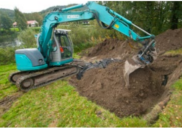
Bilde 9.13. Til slutt fylles det på med et jordlag over veiduken.
