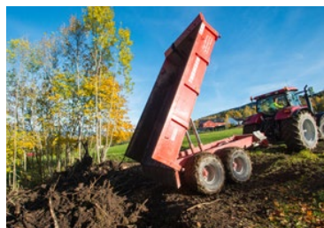
Bilde 7.3. Overskuddsmasser og røtter blir deponert på en godkjent plass på eiendommen.
