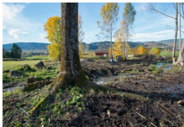
Bilde 9.3. Etter at skogen er fjernet står enkelte store trær og stubber igjen. Gravemaskinen arbeider med å legge om bekken inn i dammen.
