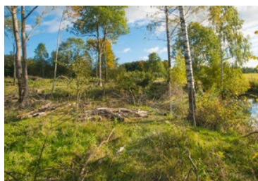
Bilde 7.2. Restaureringsarbeidet startet med å hogge skog.
