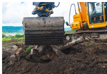
Bilde 9.4. Gravemaskinen legger rota på plass som skal bli overvintringsplasser og dagskjul for salamanderne.
