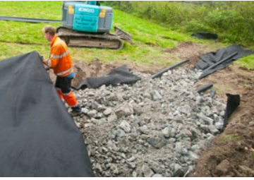
Bilde 9.12. Steinmassene er fylt på og veiduken pakkes over.
