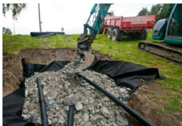
Bilde 9.11. Dreneringsrørene blir plassert i riktig nivå og retning.
