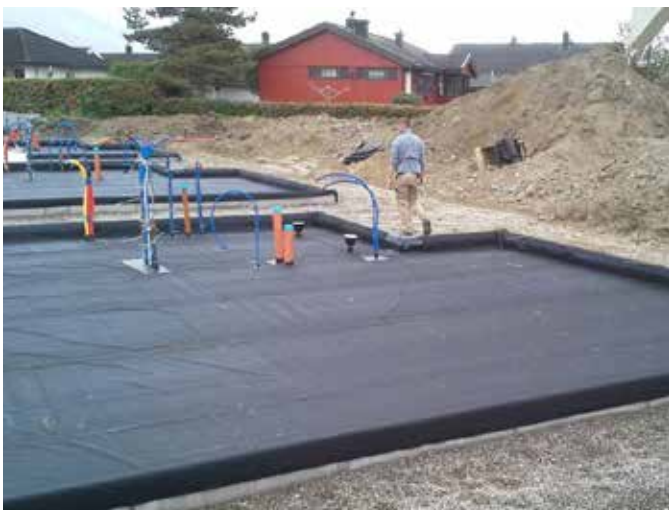
EPDM gummimembran brukt som Radon membran
