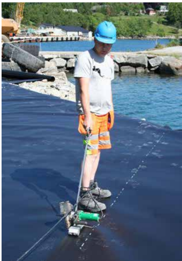
Sveising av HDPE membran med dobbeltsveis med testkanal
