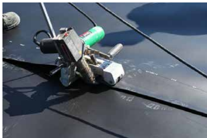
Sveising av HDPE membran med dobbeltsveis med testkanal
