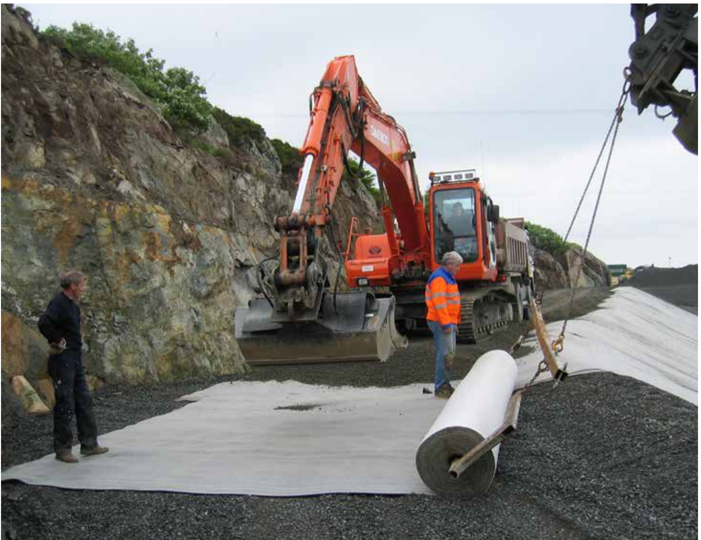
Bunntetting med bentonittmembran ved Årabrott Avfallsdeponi i Haugesund
