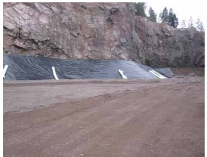
Bunntetting med bentonitt og HDPE plastmembran, Taranrød Fyllplass i Tønsberg
