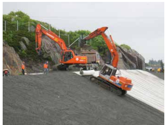
Bunntetting med bentonittmembran, Årabrott Avfallsdeponi i Haugesund
