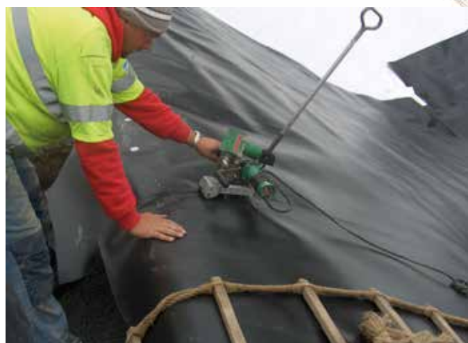
Sveising av FPP membran
