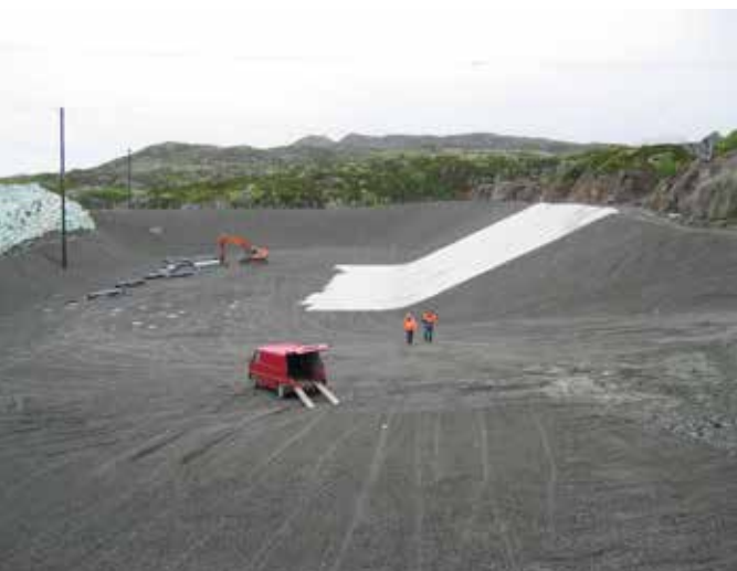
Bunntetting med bentonittmembran, Årabrott Avfallsdeponi i Haugesund
