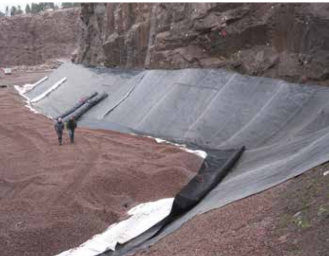
Bunntetting med bentonitt og HDPE plastmembran, Taranrød Fyllplass i Tønsberg
