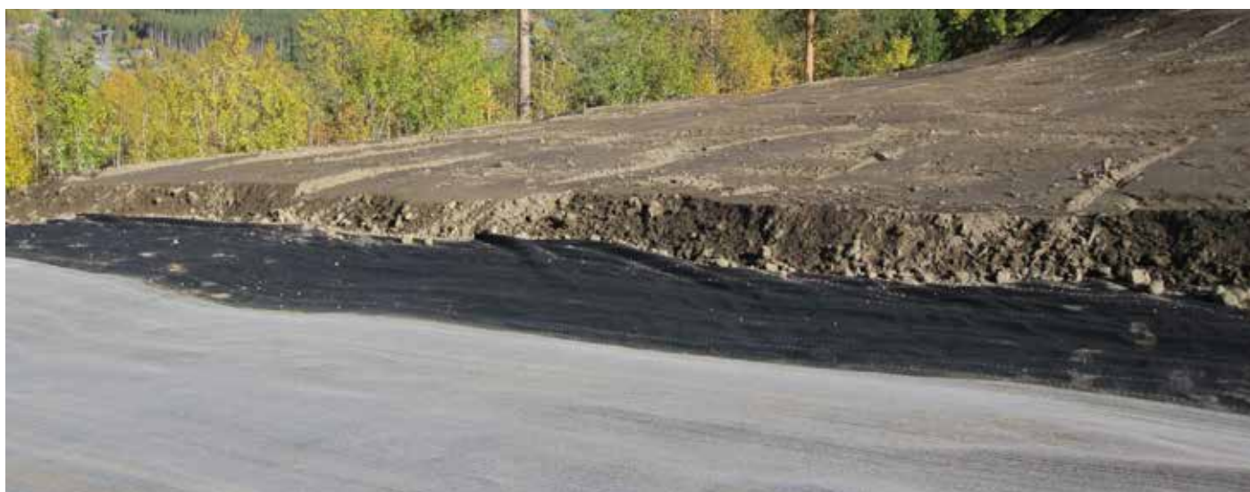
Topptetting ved Kleivl slaggedeponi i Hallingdal. Bentonittmembran og Enkadrain dreneringsmatte.
