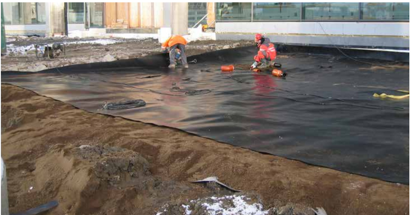
Etablering av kunstig dam ved BI-Nydalen, med FPP membran.
