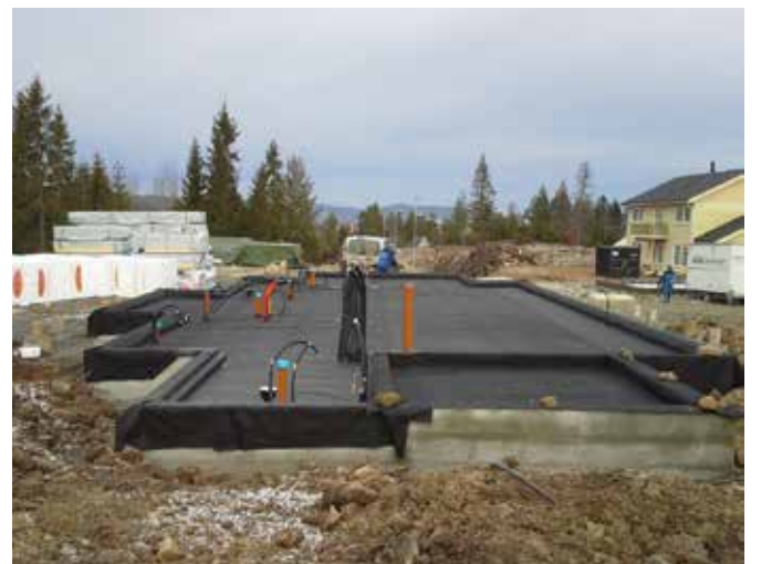
EPDM gummimembran brukt som Radon membran
