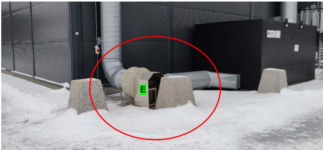
Figur 5. Punktkilde E: Ventilasjonsstøy fra teknisk bygg.
