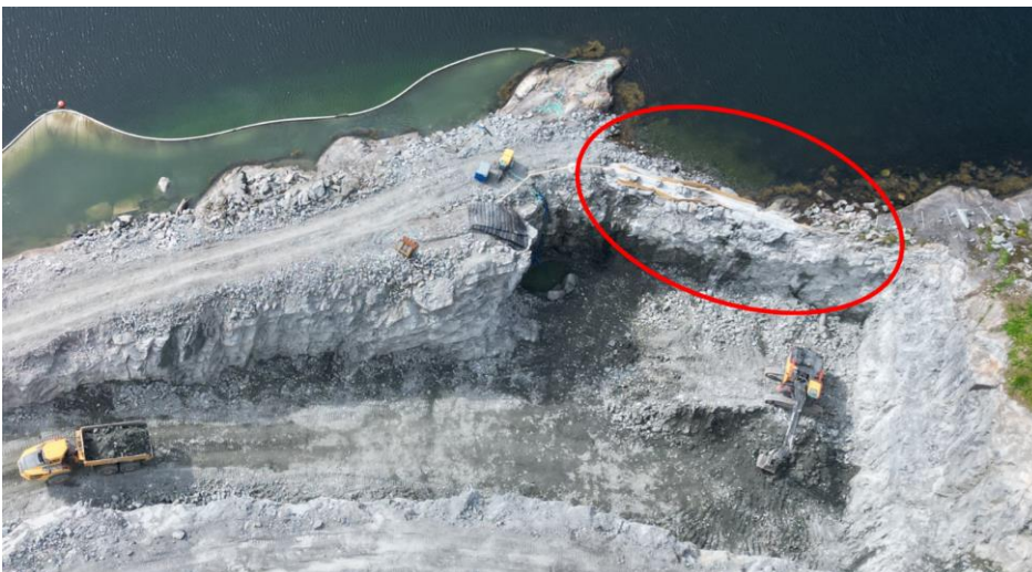
Figur 1.1: Dronebilde fra tiltaksområdet og illustrasjon av fjellmassene som planlegges sprengt bort.
