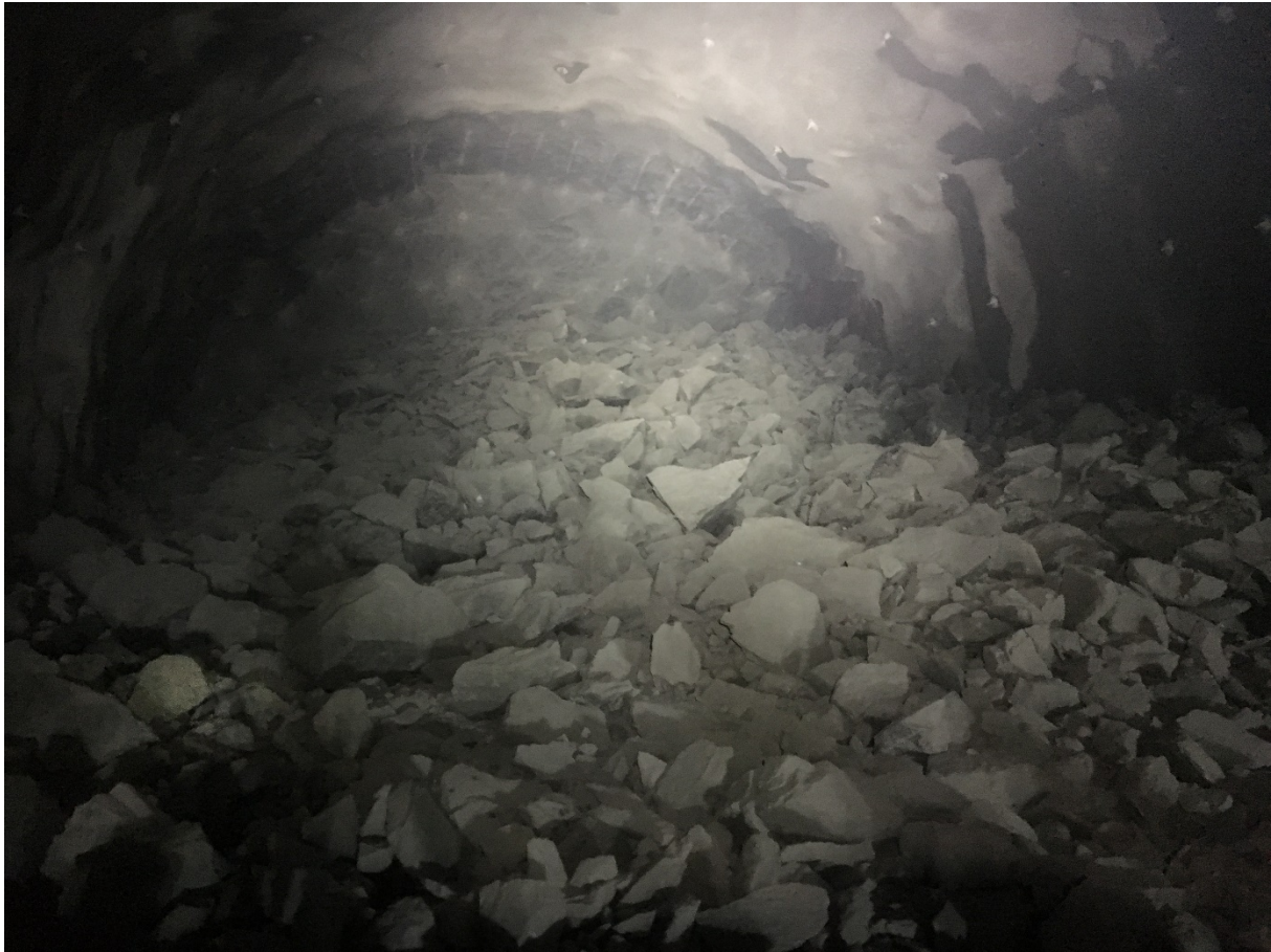
Figur 4: røysa etter ferdig skutt Testsalve 2, ca. 690 løse/anbrakte m 3
