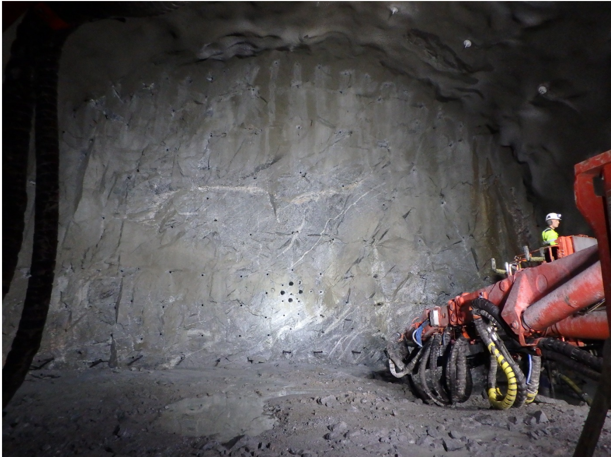
Figur 1: Ferdigboret stoff klar for lading med elektroniske tennere – testsalve 2
