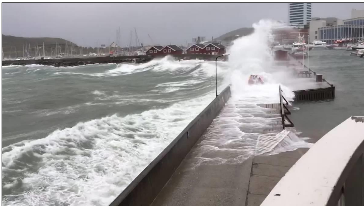
Figur 9: Eksempel på overskylling i Bodø under stormen Sally i 2020 (bølgetilstand H_s=1.4 m / T_p = 4.5 s). Molo ligger på kote +3 m (NN2000). Vannstand var 1.9 m. Gjennomsnittlig overskylling er estimert til 5 l/m/s basert på EurOtop (2018).
