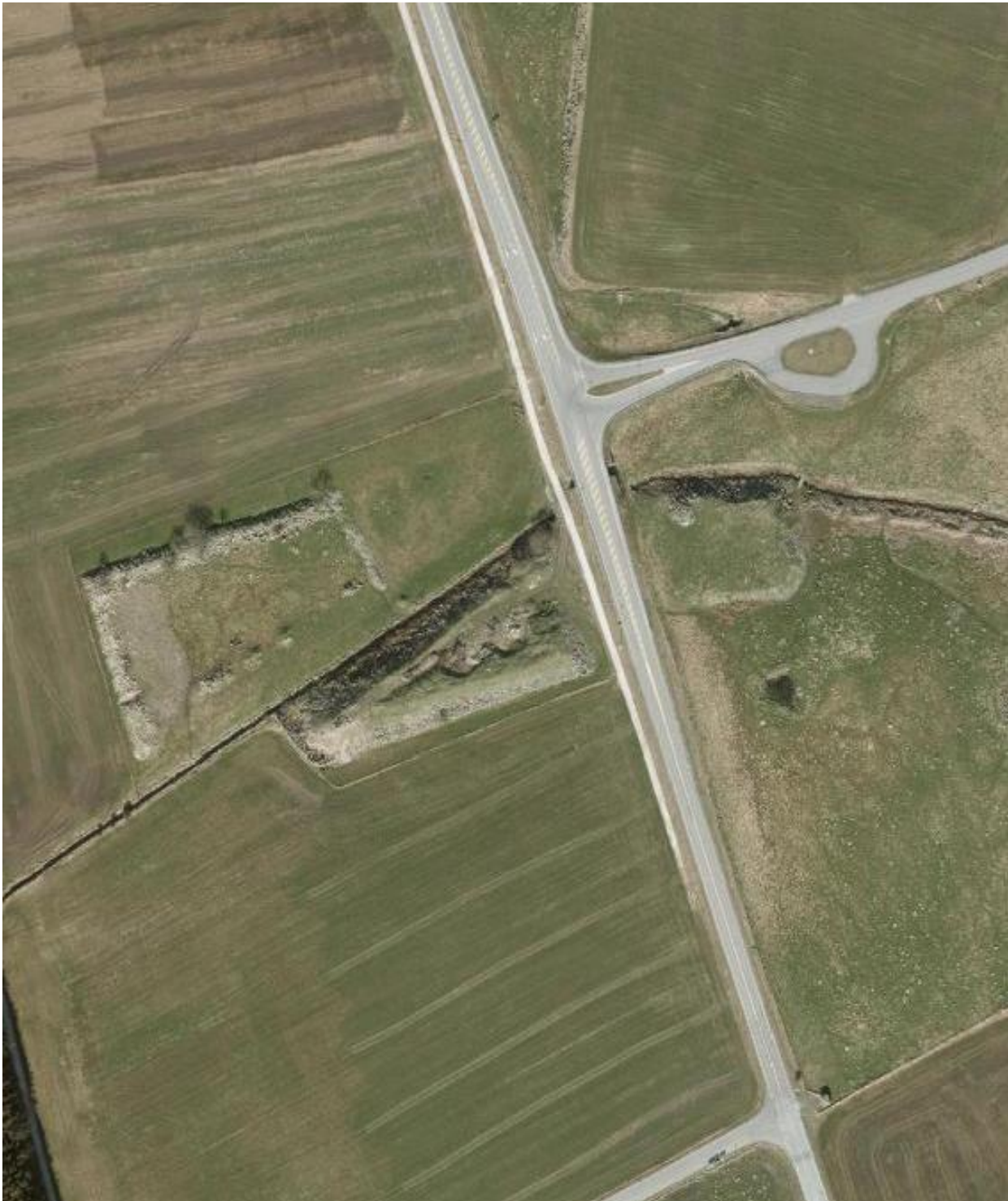
Krysset til Ivar i syd, kryss til Kviamarka industriområde i nord. Sistnevnte har blitt utviklet med blant annet venstresvingefelt og gang og sykkelveg (ikke fullført med fast dekke, virker mest å fungere som en driftsveg til massedeponi).
