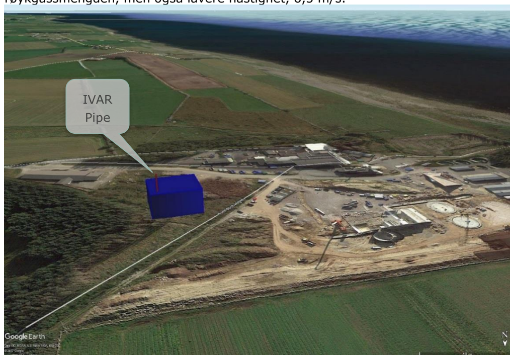
Figur 2: Oppsett av virksomheten (pipen og planlagte nærliggende bygninger) i spredningsmodellen, som sett fra nord i GoogleEarth.
