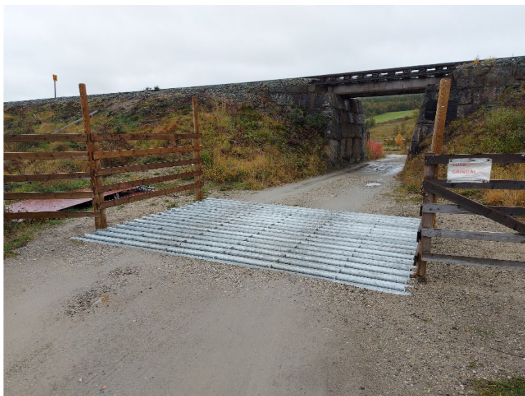
Bilde 2: Glåmos (Lerdalen) - Jernbaneundergang m/ferist. Ferista fungerer ikke. Reinen følger bygdeveien og går rett over ferista. Utfordring: Veier i hyttefelt langt opp mot tregrensa er et problem. Reinen følger disse ned til bygda, særlig vinterstid. Den vanligste typen av ferister med 7,5 cm mellom rillene er ingen stor hindring for rein (foto: I. Hansen).
