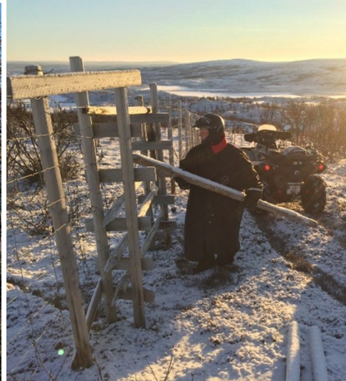
Bilde 13 a,b: Port/stolpeled med tverrgående (horisontale) bjelker. Fungerer spesielt godt om vinteren fordi stolpene kan demonteres én for én avhengig av snødybde (foto a: J. I. Kleveland, foto b: S. R. Smuk).
