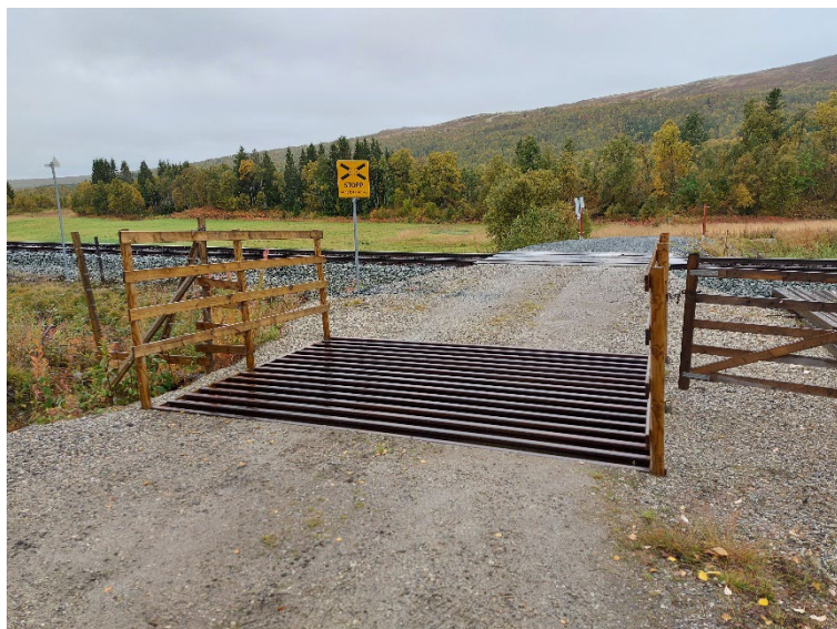
Bilde 1: Ferist og grind i tilknytning til jernbanekryssing av privat vei ved Sandtjønnan. Utfordring: Ferista alene stopper ikke reinen og grunneier ønsker ikke å ha grinden lukket når eiendommen benyttes (foto: I. Hansen).
