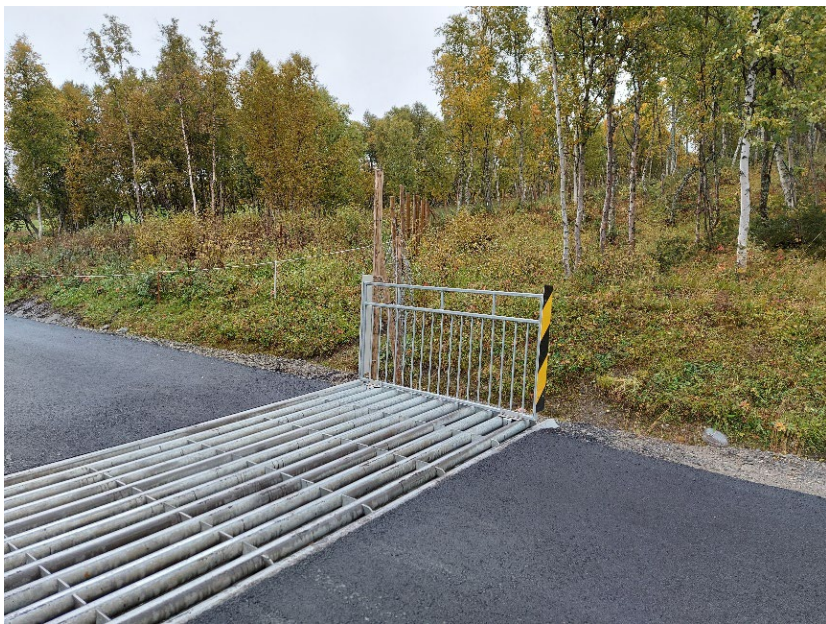
Bilde 11: Nylig montert, standard ferist i nordenden av sperregjerdet ved Aursunden. Denne fungerer også dårlig mot rein pga. for liten avstand mellom rillene. Dette resulterer i at reinen kommer seg inn på feil side av sperregjerdet fra nord-øst (foto: I. Hansen).
