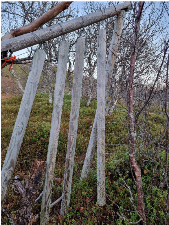
Bilde 14: Port med vertikalt hengende stolper som kan skyves til side for gjennomgang. Stolpene beveger seg litt i vind og fungerer dermed også som avskrekking for reinen. Denne portløsningen ble også anbefalt av informanten fra Røros JFF som en god løsning for jegerinteressene (foto: J. I. Kleveland).
