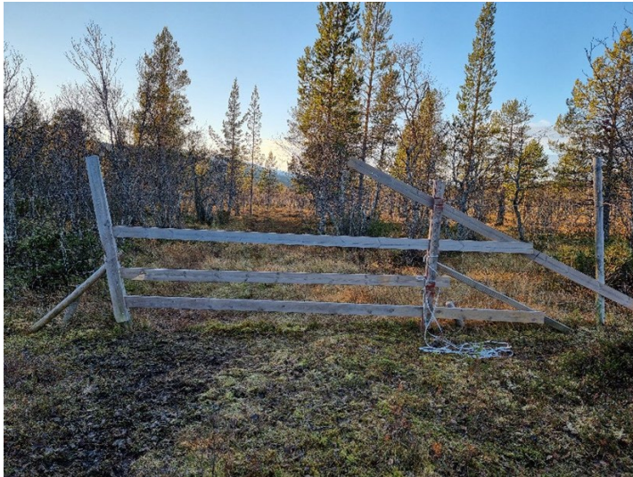
Bilde 13 a,b: Port/stolpeled med tverrgående (horisontale) bjelker. Fungerer spesielt godt om vinteren fordi stolpene kan demonteres én for én avhengig av snødybde (foto a: J. I. Kleveland, foto b: S. R. Smuk).
