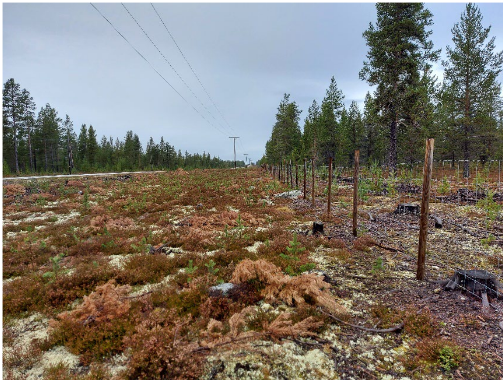
Bilde 5: Drevsjøgjerdet, et eksempel på sperregjerde som fungerer godt. Gjerdeanlegget har et fåtall passeringspunkter og er oppført tett innpå bebyggelse og annen infrastruktur, slik at tilsyn og vedlikehold blir enkelt (foto: I. Hansen).
