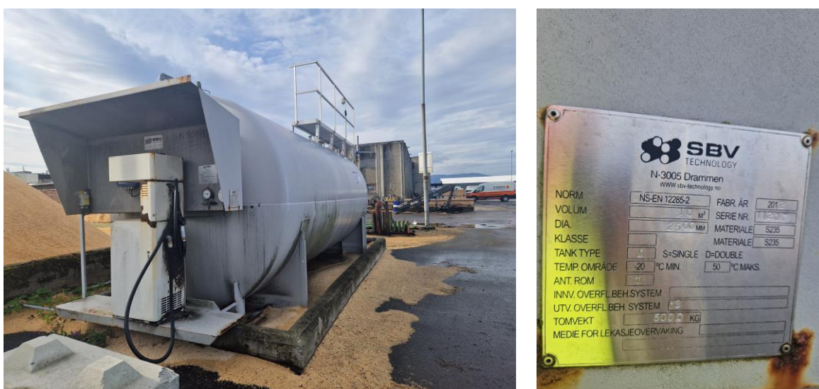
Figur 7. Bilde og spesifisering for tanken på 30 m 3 som benyttes til lagring av diesel.
