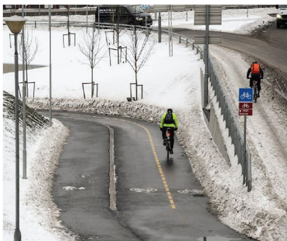
Figur 16: Vintervedlikehold. Foto. Statens vegvesen
