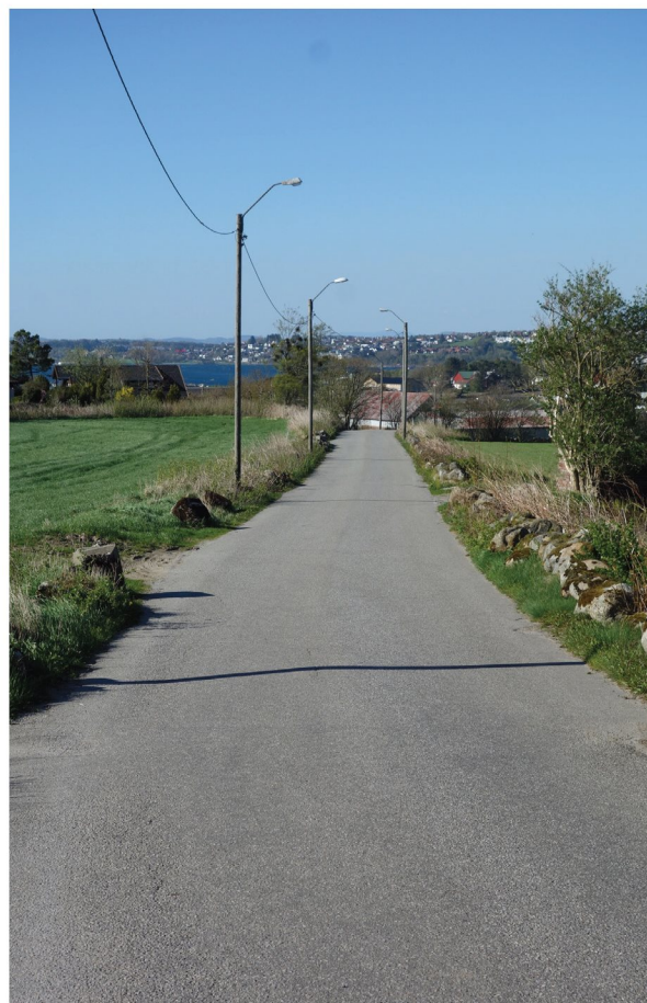
Figur 10: Turrute mellom Nesbuvegen og Forus. Foto: Sola kommune
