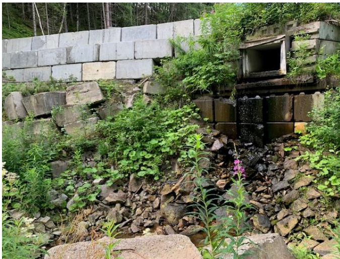
Figur21 Utløp av kulvert under deponiet
