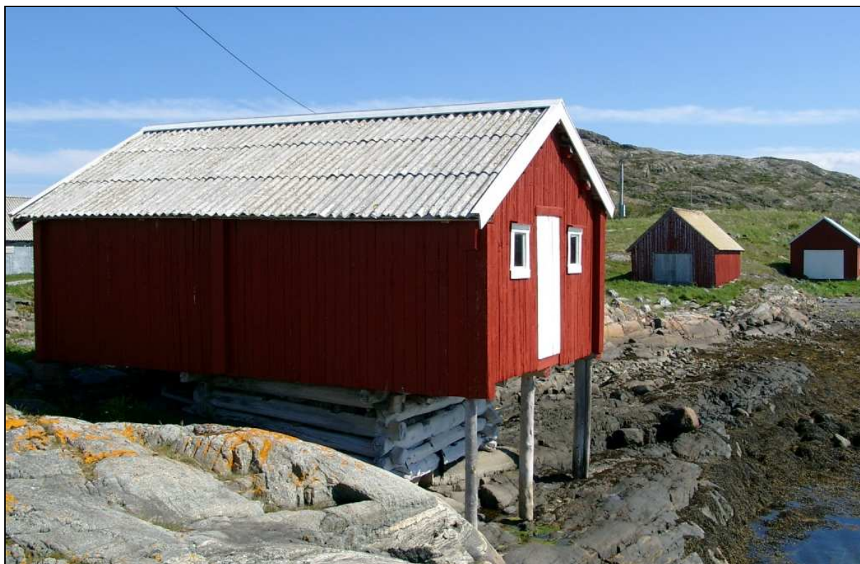
Figur 5. Denne Brygga i Skjåvika er en av de eldste bygningene på Linesøya og fremstår i god stand. Den er bygd på en gammel, tradisjonell måte med et fundament som består av en tømmerkasse fylt med stein. Brygga er del av et kulturmiljø med flere naust liggende i en bue rundt bukta.
