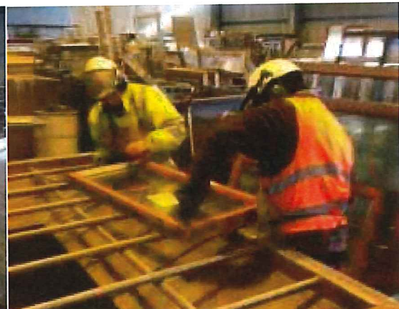
Skjæring med glassmesterkniv for knusing med øksehammer
