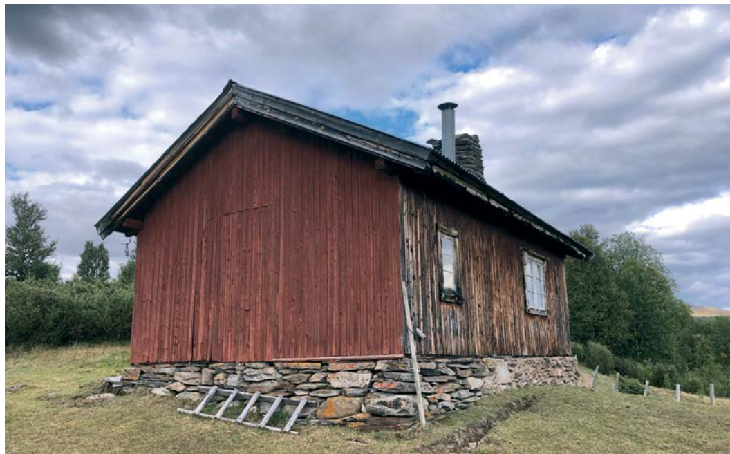
Plassætra på Kvikne står på en solid mur som tar opp terrengfallet.
