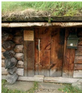
Labankdør med brede bord, Museumssetra, Synnerdalen
