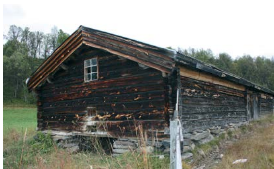
Det er bare mange år med sol, vind og vær som har satt farge på dette seterfjøset på Ustuvollen, Øyan i Vingelen.
