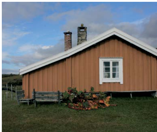
På Strømsøyvangen er det to piper, ei gammel gråsteinspipe, og ei murt teglpipe fra ca 1955.
