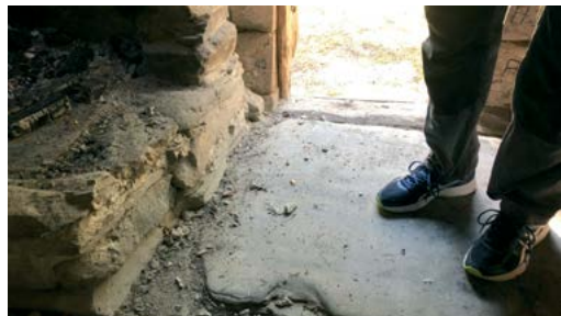
Gulvet i slåttebuene kan være et enkelt jordgolv, eller belagt med steinheller.
