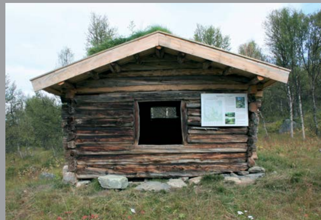
Restaurert løe i Nygardsenget i Vingelen. Her er det brukt tømmer av furu, og takoverbygget er også relativt stort (ca 1 m).
