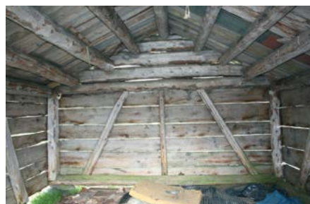
Skjelterkonstruksjonen er en materialbesparende byggemetode og er mye brukt i både fjøs, løer og andre mindre bygninger. Her er det brukt liggende panel, men som oftest er det brukt stående panel. (Se s. 33)
