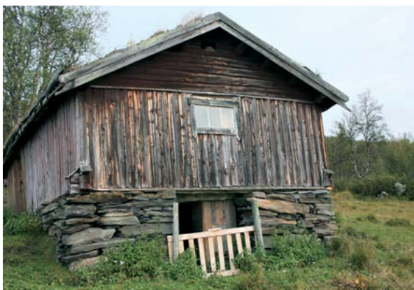
Bordfjøs med murt møkkjeller, Mastukåsen i Vangrøftdalen
