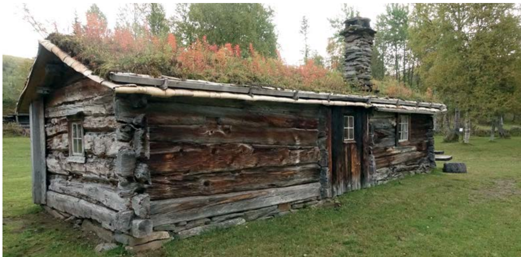
Denne seterstua, Volla-Vollbua fra 1863, har ikke vindskier. Det er bare nevra som stikker ut som avslutter takkanten. Den står på Museumssetra i Synnerdalen.
