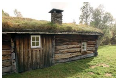
Gluggen plassert med ulik høyde på vegg.
