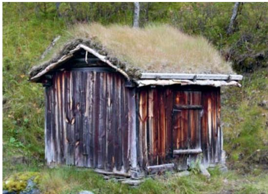
Avkjøling i grovt bindingsverk, Mastukåsen i Vangrøftdalen.
