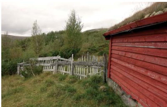
Eksempler på bruk av liggende kledning.
