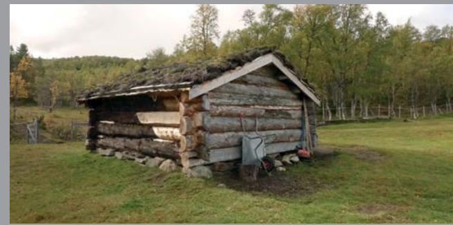
Reparasjon av tømmervegg, Bruavollen i Synnerdalen
