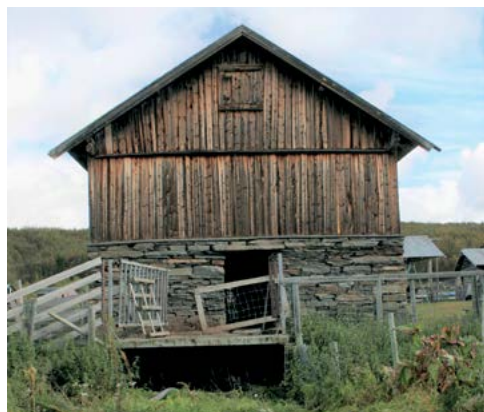
Murt seterfjøs med lem i 2. etasje, Paurengvangen Magnillsjøan. (Bygd 1869)
