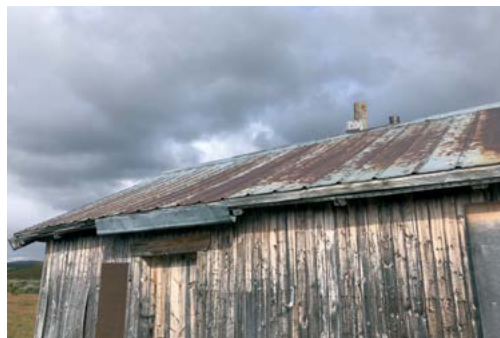
Denne gamle seterstua ved Grønntjønnan har tak med kledning av stålplater med fals.
