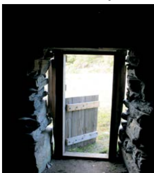
Ei todelt dør tillater lufting samtidig som dyr holdes ute.
