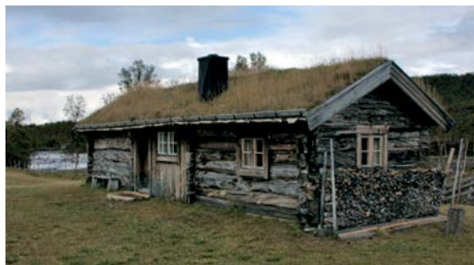
På ei anna seterstua på Hiåvolla i Endalen er det brukt pipe med stålbeslag.
