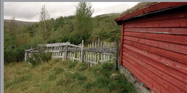
Gjerde av stående bord (en type stakitt) på Raudåvollen ved Øyungen
