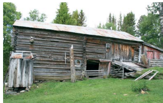
Det finnes noen få fjøs med laft i to etasjer. Dette står på Smedsetra i Nåverdalen (Foto: Per Hvamstad)
