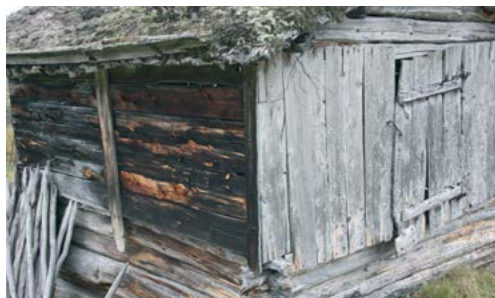
Eksempler på bruk av liggende kledning.
