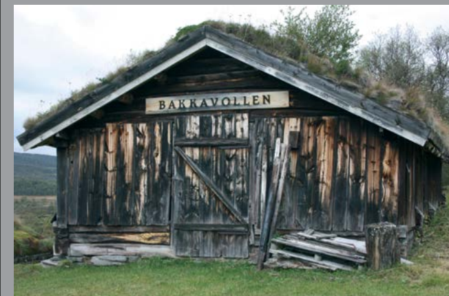
Bordfjøs med grovt bindingsverk i Mastukåsen, Vangrøftdalen
