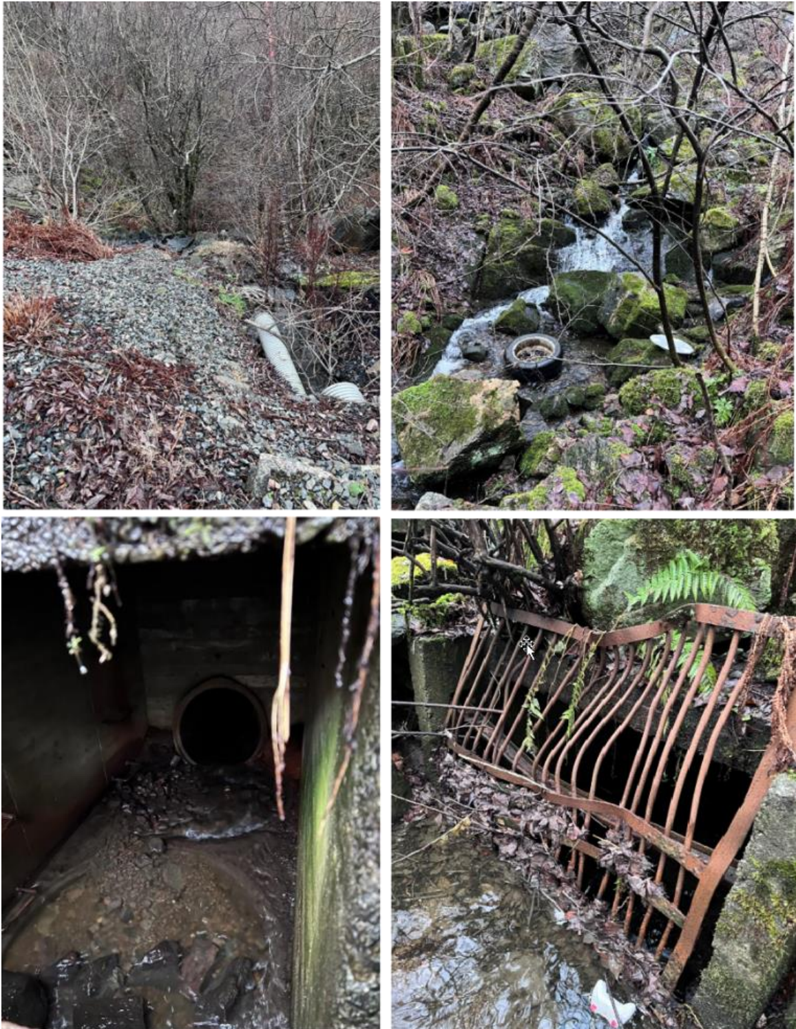
Figur 5: Foto ved Multiconsult 2022. Øverst til venstre: utløp fra 500 mm kulvert i grøntområde hvor det ligger en gammel fylling i grunnen. Øverst til høyre: Overvann drenerer på gammel fylling. Nederst: Innløp 800 mm overvannsledning nedstrøms fylling.
