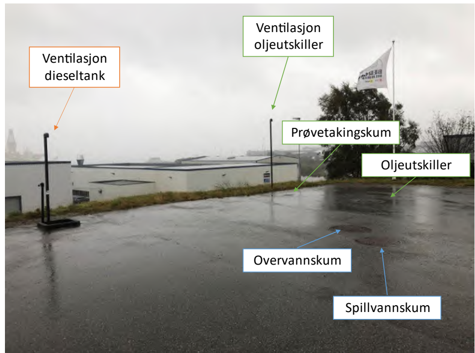
Figur 18: Bildet er tatt fra nordvest mot sørøst og viser plassering av oljeutskiller, dieseltank og septiktank på kundeparkering (Foto: COWI AS).
