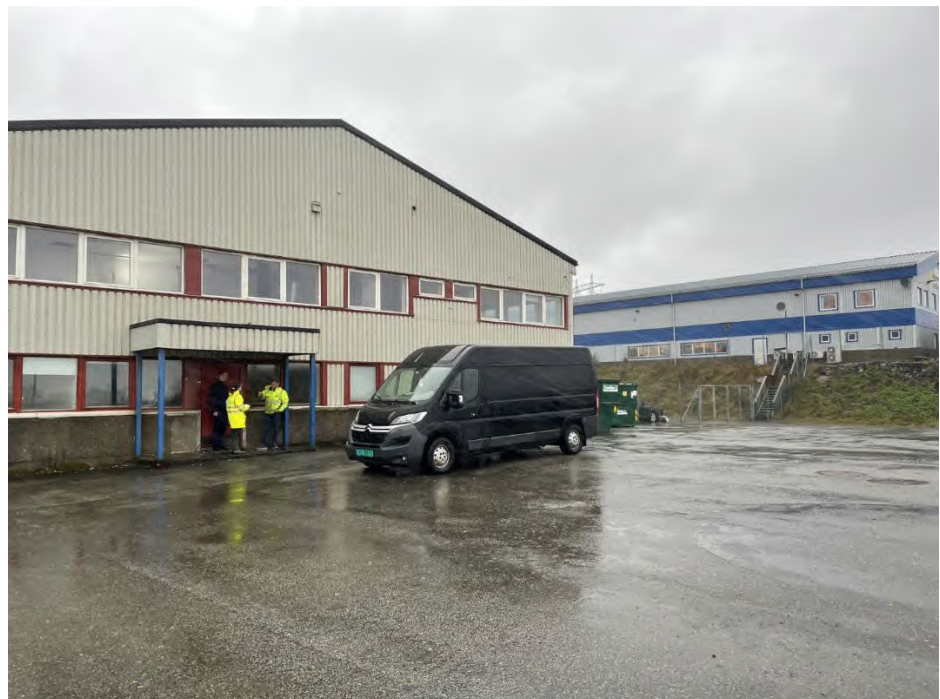
Figur 10: Kontor og butikklokaler utvendig, i forkant sees kundeparkering (foto: COWI, tatt fra sørøst mot nordvest).
