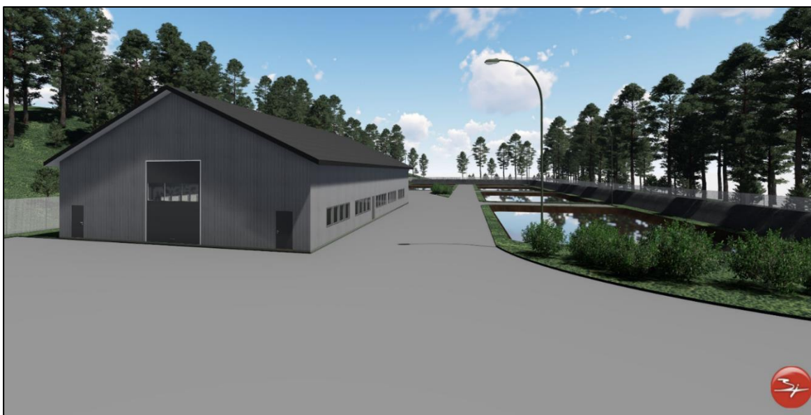
Figur 14: Illustrasjoner utarbeidet av firmaet Bjerke teknisk design i Veggli. Bildene viser bygg for mekanisk avvanning av slam, laguner for infiltrasjon av rejeftvann og asfaltert flate for rankekompostering av slamm.
