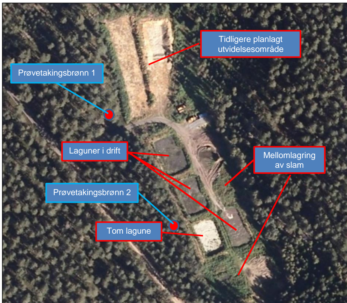
Figur 5: Flyfoto som viser slamlaguneanlegget med 4 bassenger for avvanning av septikslam, samt arealer for mellomlagring av slam. Det er etablert 2 filterbrønner i sand- og grusmasser, som er satt ned til grunnvannet, for dokumentasjon av løsmassenes renseeffekt for avløpsvann.
