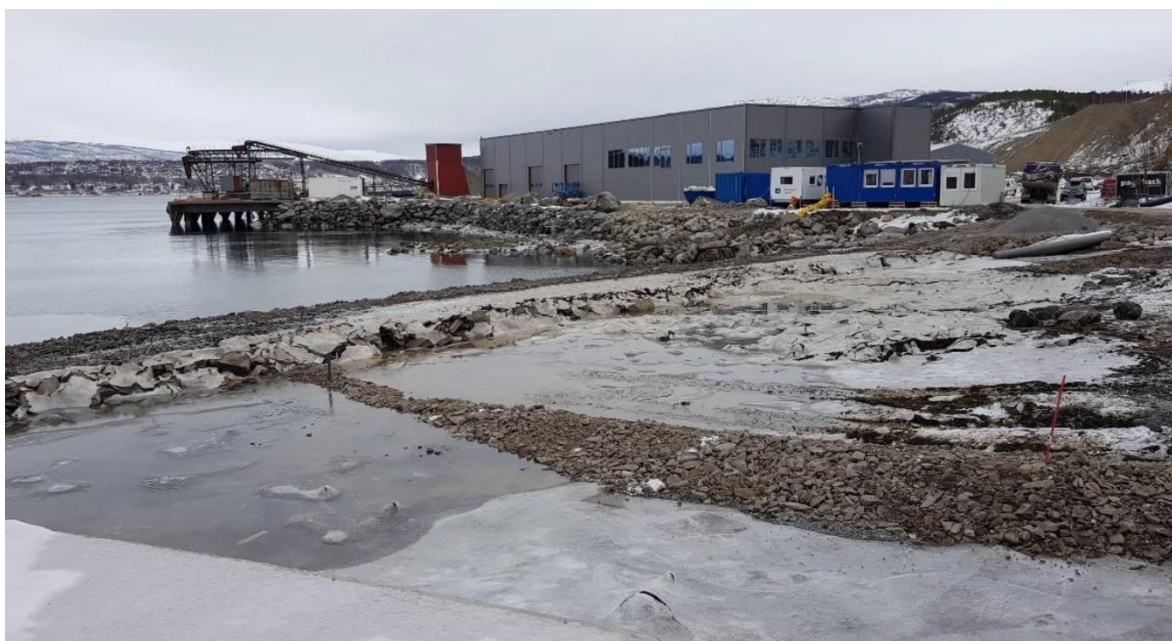
Figur 7. Kilde: Bukta hvor det planlegges utfylling i sjø, sett mot det nye administrasjonsbygget. Th. I bildet kan man se pågående masseuttak. Kilde: Østbø 2019
