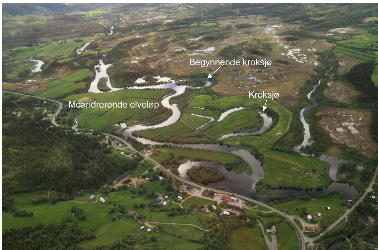
Figur 1. Et meandrerende parti i Moldåga, Nordland (sett nordfra). Her vises både kroksjø og meandring, samt begynnende avsnøring av ny kroksjø. I tillegg vises en typisk situasjon, med dyrket mark, dreneringsinngrep etc. Foto: Trond Simensen, Sweco Norge.
