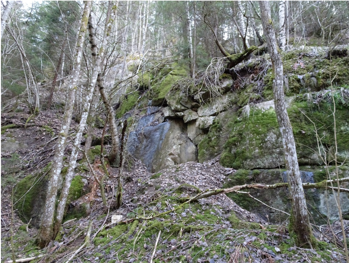
Bilde B2 Oppsprukket berg – (observasjonspunkt "Svakhetszone" – se figur B1)
