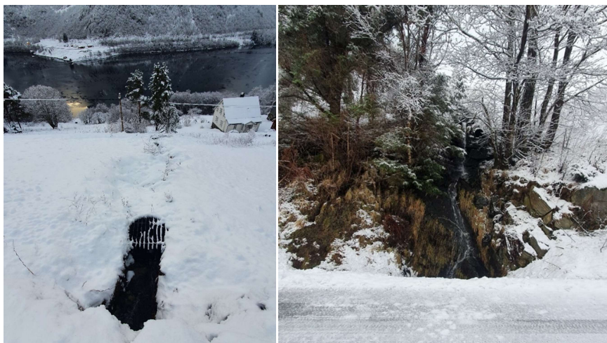
Figur 12 Til venstre SØ4: Bekken renner under veien og rett ned i kuvert som går rett ned til sjøen. Til høyre SØ5: Liten vannføring selv med smeltevann og nedbør.
