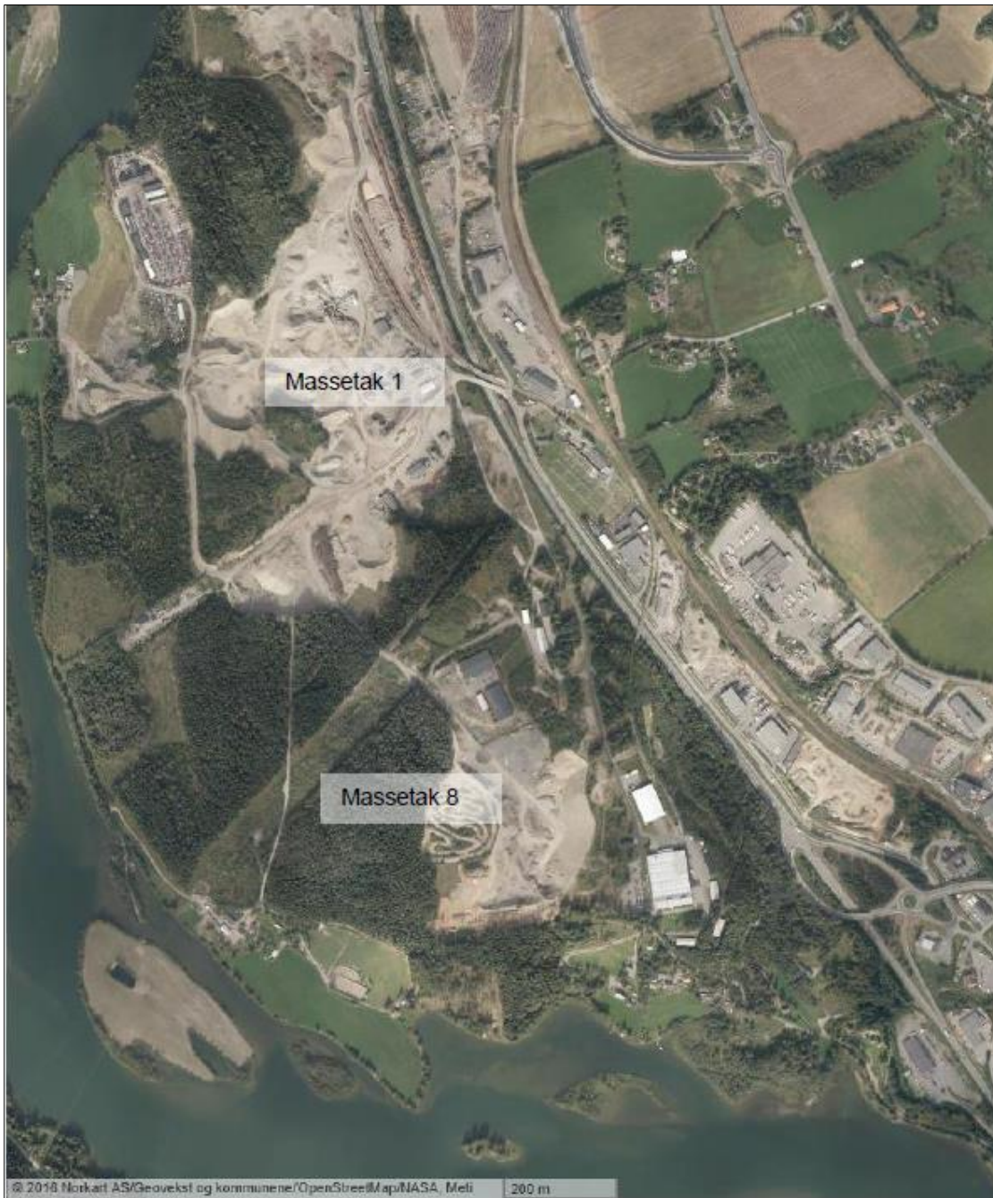
Figur 17. Flyfoto fra 2014 som viser aktive uttaksområder for sand og grus på Hovemoen. Ny planlagt E6 kommer til å krysse massetak 1.
