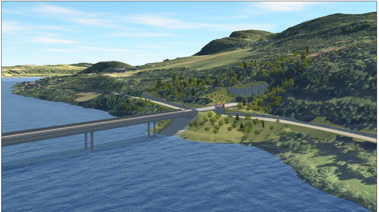
Figur 21. Tunnelpåkutt ved Trosset hvor veien går rett fra tunnel og ut på brua over Lågendeltaet. Illustrasjonen viser justert linje med kassebru.
