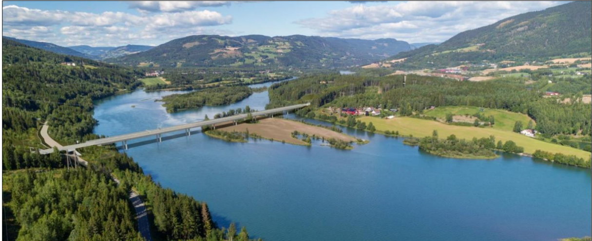
Figur 10. Lågen bru i justert linje, betongkassebru.
