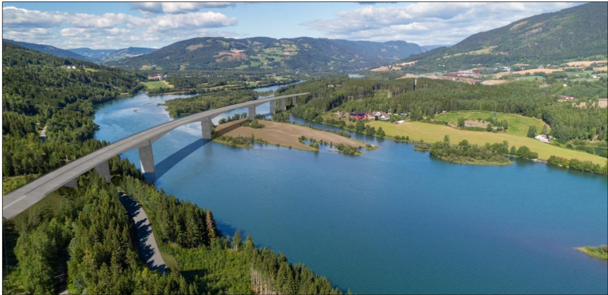
Figur 11. Lågen bru i kommunedelplanlinjen, fritt frembygg-bru.
