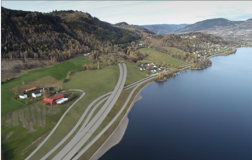
Figur 20. Illustrasjonskart av tunnelåpningen i Øyresvika.
