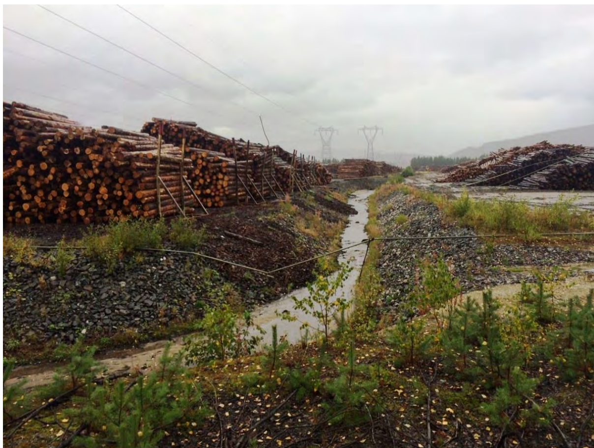
Bilde 4: Drensgroften gjennom området hadde 15.09.15 en vannføring på 20-30 l/sekund på grunn av intensiv nedbør. Det hadde ikke vært vanning siden slutten av august.
