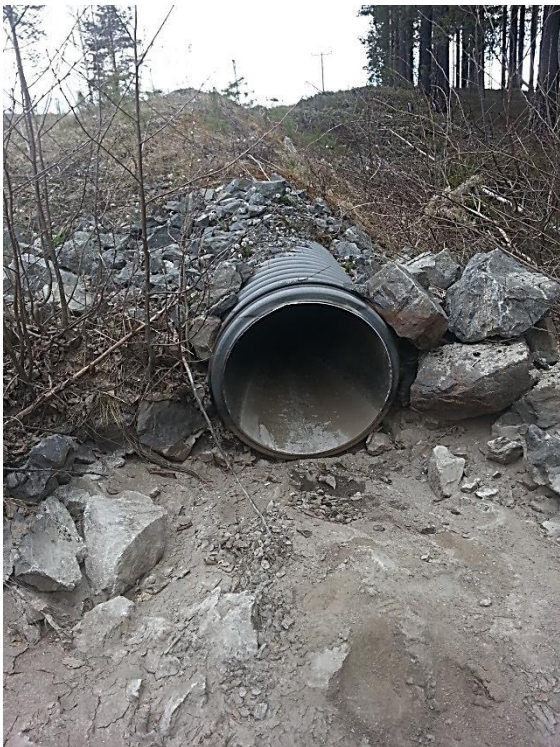
Figur 1. Dreneringsgrøft til målepunkt uten og med avrenning øverst. Rør hvor det ble montert måleutstyr (høydemåler med trykksensor) nederst. Rørets fall, vannhøyde og profil bestemmer vannmengden basert på en vannføringsformel for strømning i rør.
