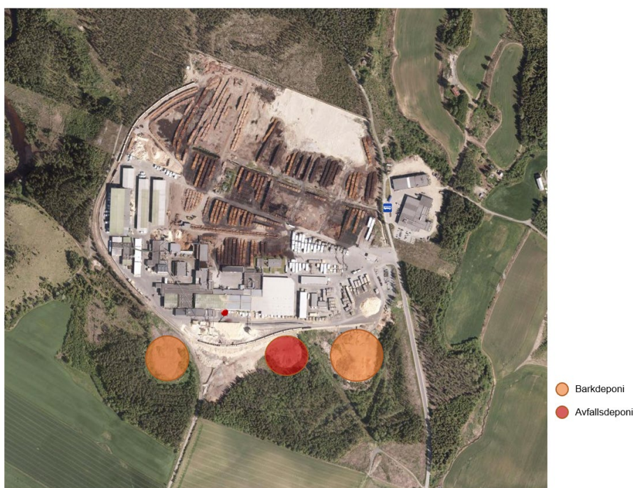
Figur 2 Avfall- og barkdeponi på eiendommen.
