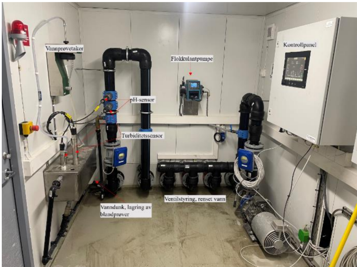
Figur 4. Mogeleg løysing for prosesscontainer med pumper, ventilstyring, kontrollpanel, sensorar og vassprøvetakar for Nye Økselnevlane kraftstasjon
