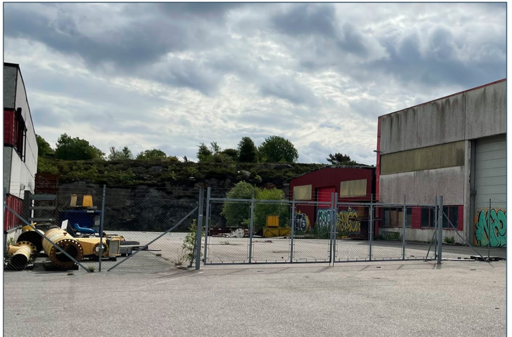
Figur 7 Foto fra vest mot øst som viser inngjerding av området mellom bygg 1 og bygg 2-3. Det er fall nedover mot øst (foto: COWI).
