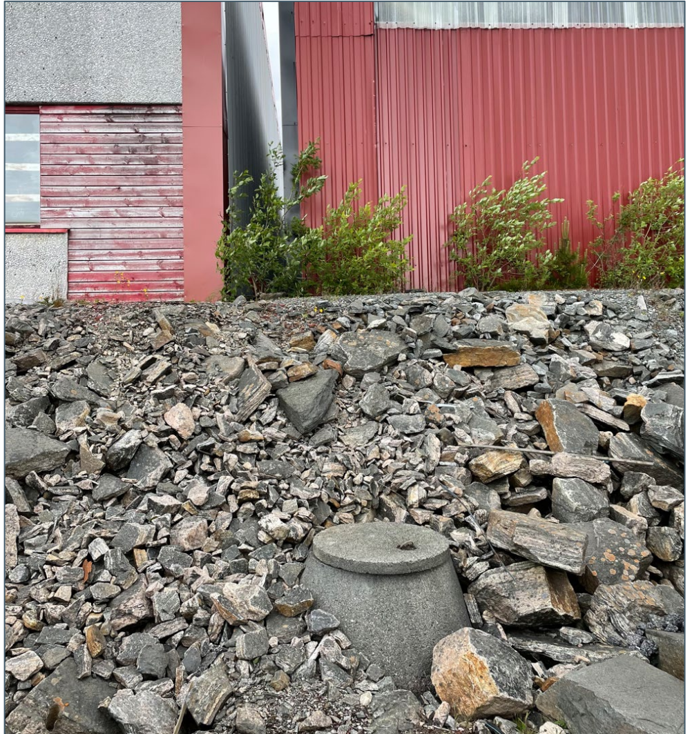
Figur 12 Foto fra sørsiden av området som viser at eiendommen ligger på en høyde, med drenerende masser langs sørsiden av eiendomsgrensen. Som vist av bildet ble det lokalisert en avløpskum sør for byggene.
