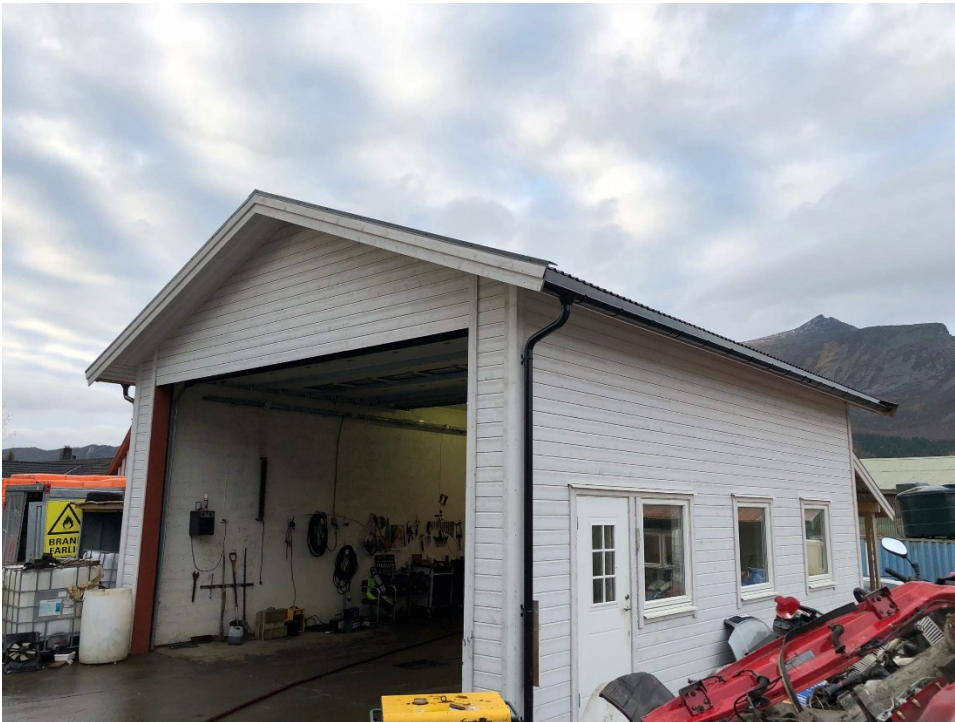
Produksjonslokale med tette flater.
