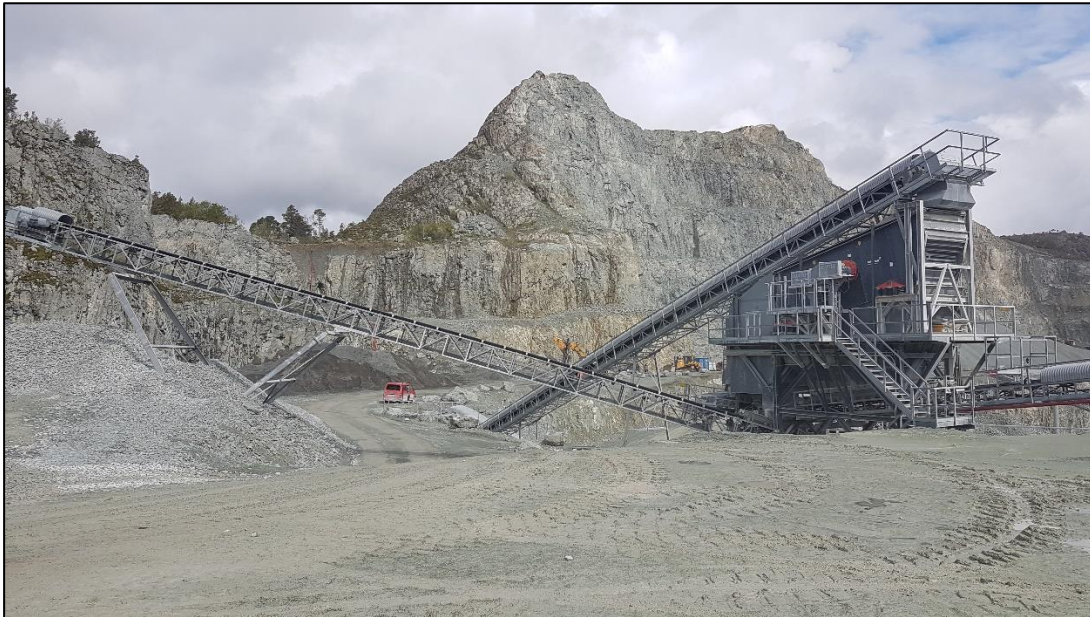
Figur 14: Før-situasjon: Foto fra Ottersbo steinbrudd tatt i mai 2021
