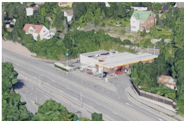
Figur 12: Bensinstasjon ved E18 som skal rives. Plassering vist i Figur 7
