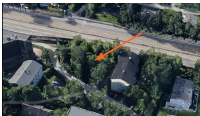
Figur 10: Kolle ved Riiser-larsens vei som skal fjernes ved sprengning.
