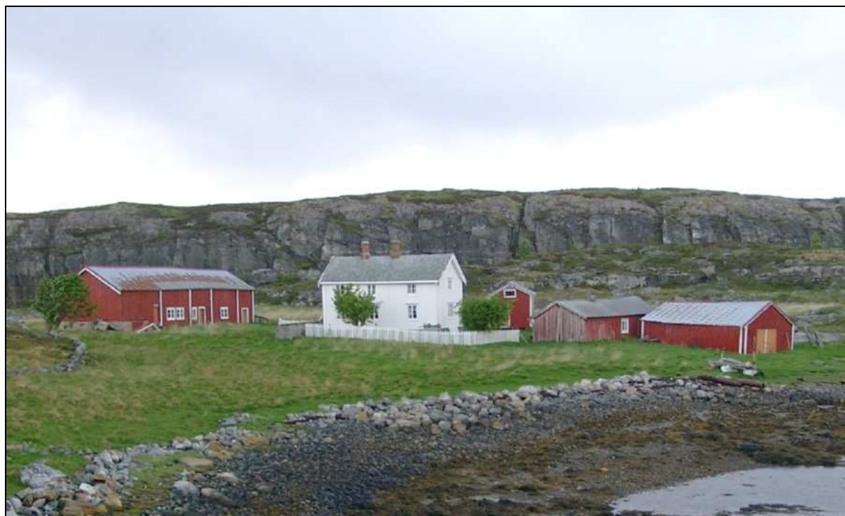
Figur 19. Bygningene på Tranøya er i forholdsvis god stand og utgjør et spennende kulturmiljø. Gården er typisk for de små kombinasjonsbruka som før var så vanlige på kysten. På Tranøya er både innmark og utmark bevart og tydelig skilt med steingard. Innmarka er blitt noe tuete, mens lyngheia fortsatt er åpen.
