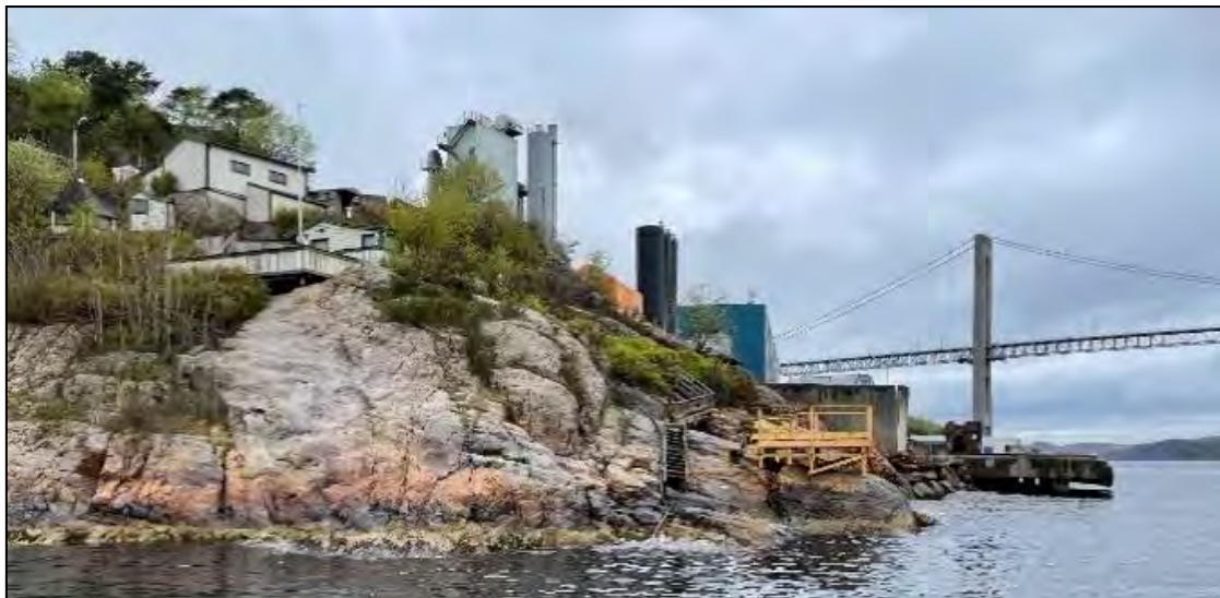
Figur 1.3. Brutårnene til ny Sotrabru vil etableres ved kystlinja i Knarrvika på eksisterende svaberg og betongkai. Hyttebebyggelse ses foran til venstre i bildet, og industribebyggelse og betongkai sees bak i bildet, samt eksisterende Sotrabru. Foto: Norconsult.
