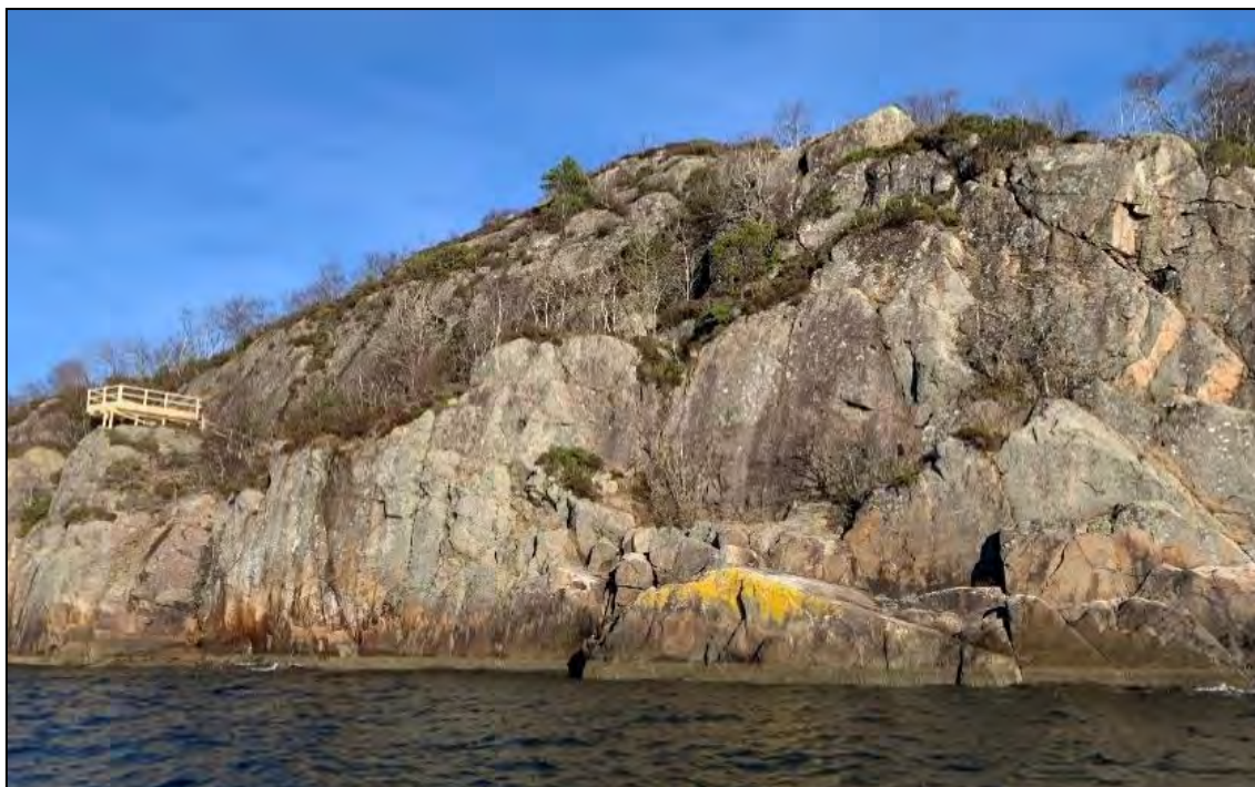
Figur 1.5. Brutårnene på Søre Drotningvik skal etableres på et platå som skal sprenges ut i fjell. Foto: Norconsult.
