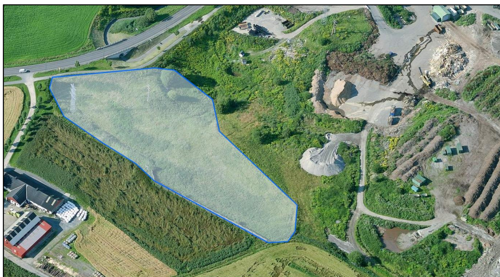
Figur 4: Vestre del av anlegget hvor det ifølge Sarpsborg kommune ikke er deponert masser tidligere.
