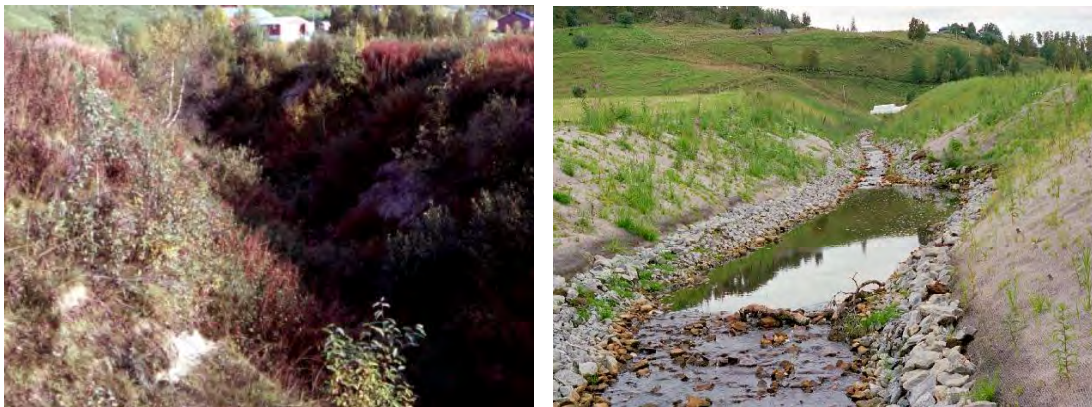
Figur 2 . Jordbrukskanalen fra Bruksåsmoen før og etter at tiltak ble gjennomført for å stoppe erosjon og slamtransport fra denne til Børselva. (Foto K. J. Aanes)
