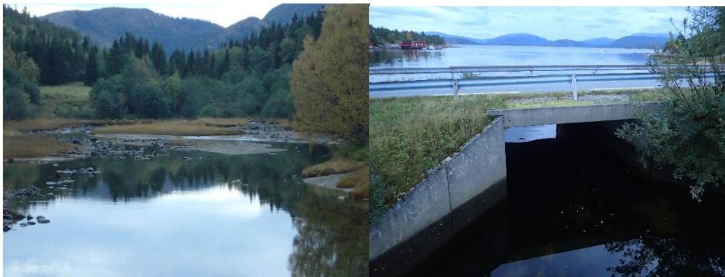
Bilde: Nedre deler av Fiskeroselva (t.v.) og betongbru ved utløp i sjø (t.h.).
