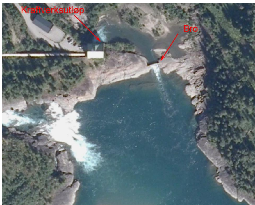
Figur 4. Oversikt over kraftverksutløpet i Reinforseia kraftverk i Rana. Distansen mellom utløp av kraftverket og broa er ca 80 meter.
