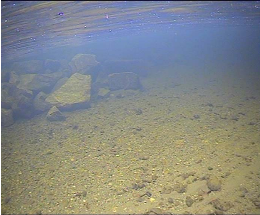
Bilde 13. Strømviser som er lagt ut i terskelbassenget i Berghølla. Denne øker vannhastigheten samtidig som det grove substratet skaper oppvekstområder for laksunger.
