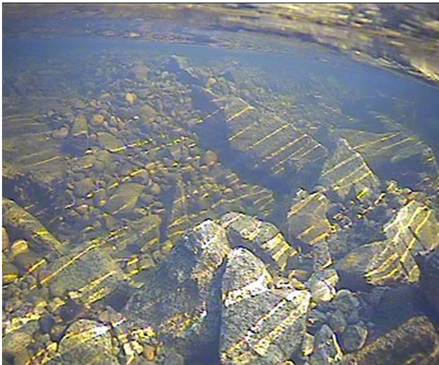
Bilde 10. Berghøllaterskelen etter restaurering. Det nye substratet skaper både nye gyteplasser og oppvekstområder for laksunger.
