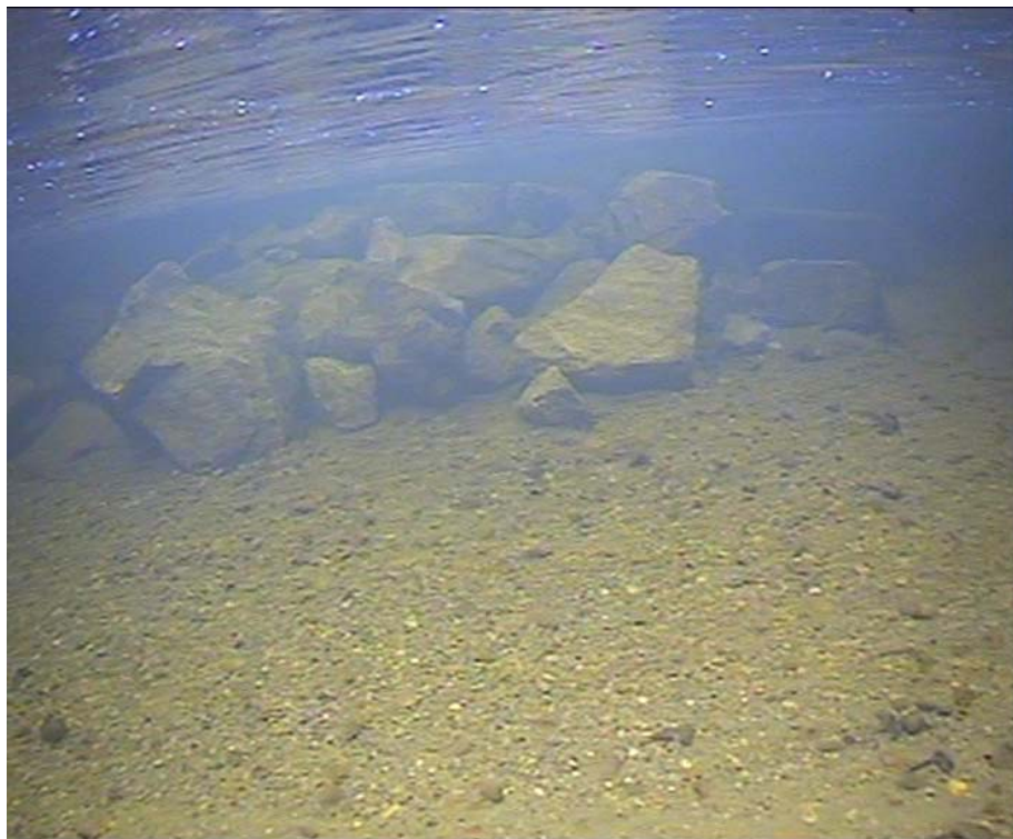
Bilde 14. Strømviser i terskelbassenget i Berghølla.
