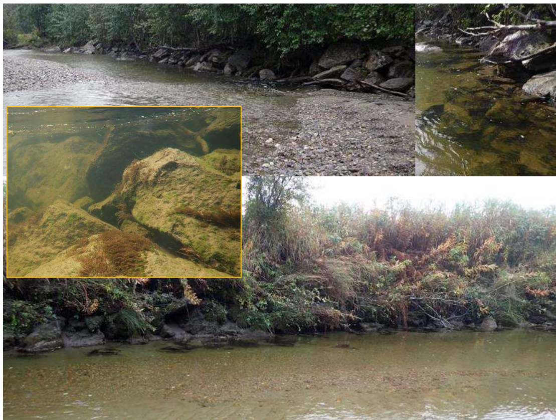
Figur 33. Eldre storsteinforbygninger gir gode skjulmuligheter for ungfisk i Slettenelva, og bidrar til god produksjonsevne for ungfisk i forskjellige størrelser, til tross for en elvbunn med naturlig lav skjulkapasitet og dårlige oppvekstområder. Foto: NINA.
