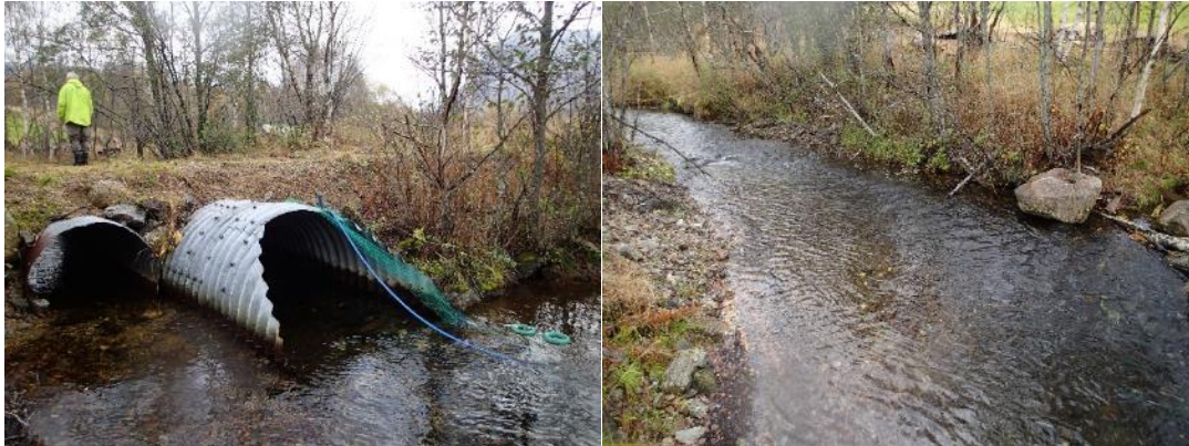
Figur 31. Mølnelva. Kulvert under gårdsvei og aktuell gytestrekning. Foto: Aslak Darre Sjørnsen
