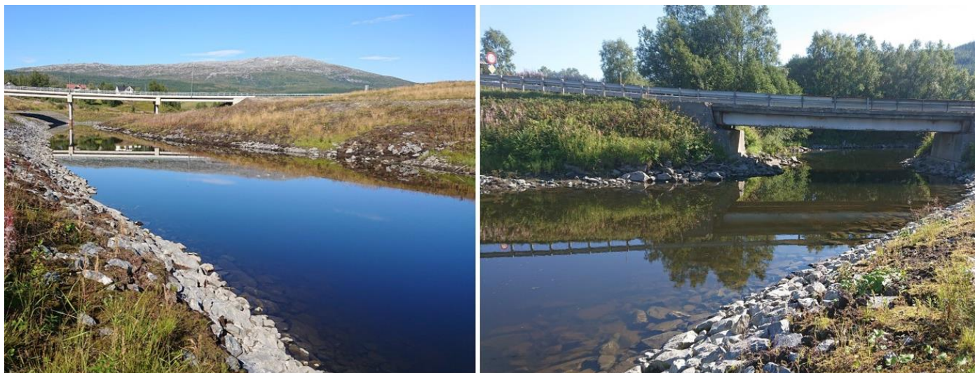
Figur 24. Baåga. Foto t.v.: Sett oppstrøms mot ny E6. Foto t.h.: sett nedstrøms mot gammel E6. Elvekant etablert med plastring/erosjonssikring med sprengstein. Djupålen domineres av finstoff.
