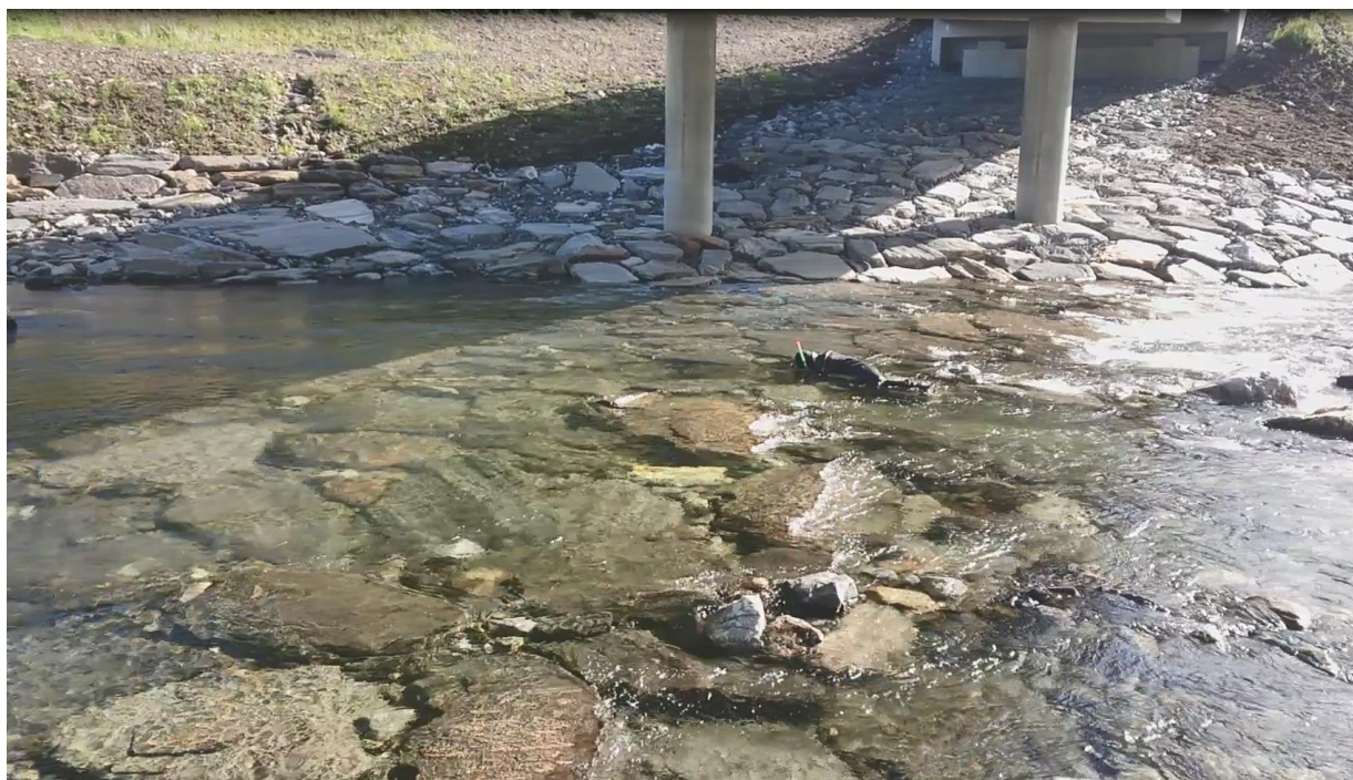
Figur 36. Bunnplastring ved transekt 3 og 4 har medført betydelig endring av bunns substrat fra før- til etterundersøkelser av skjul/hulrom.
