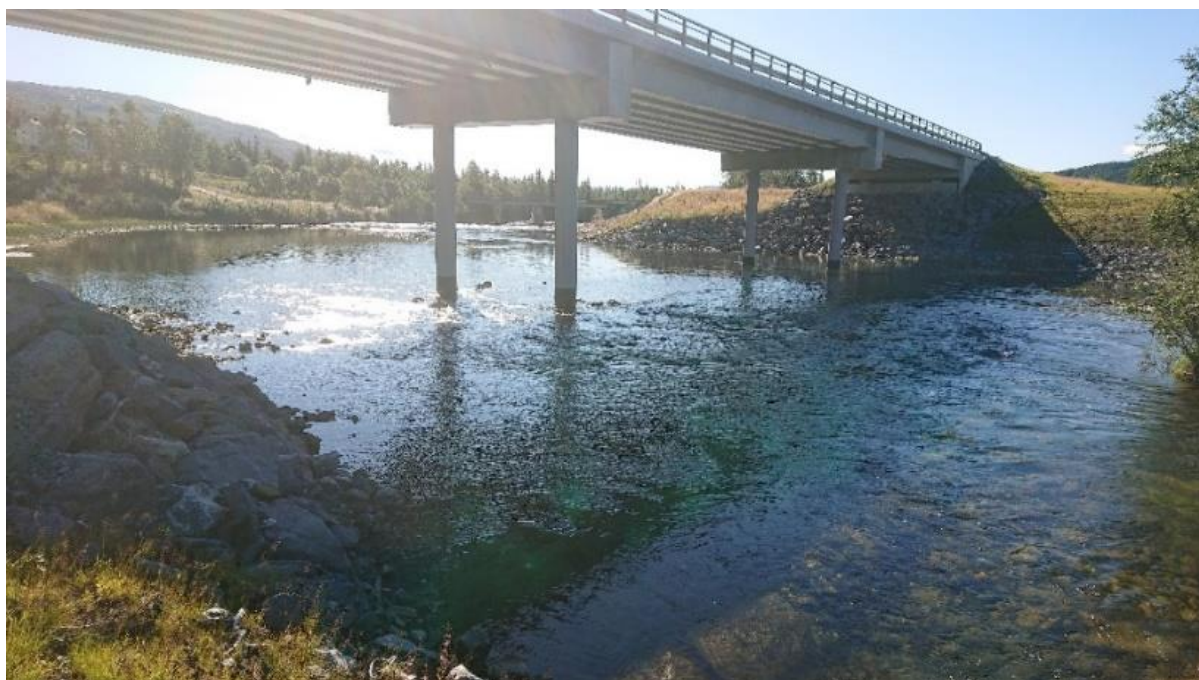
Figur 37. Ny erosjonssikring med sprengstein på oppstrøms side av ny bro ved transekt 8 har medført betydelig økt skjul i forhold til før-situasjon.
