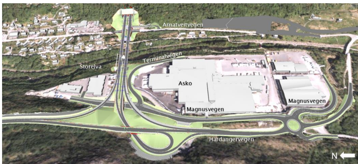
Figur 5-28: Ny situasjon i Arnadalen. Nye bruer over dalen, nytt lokalvegssystem og ny tilkopling til Hardangervegen
