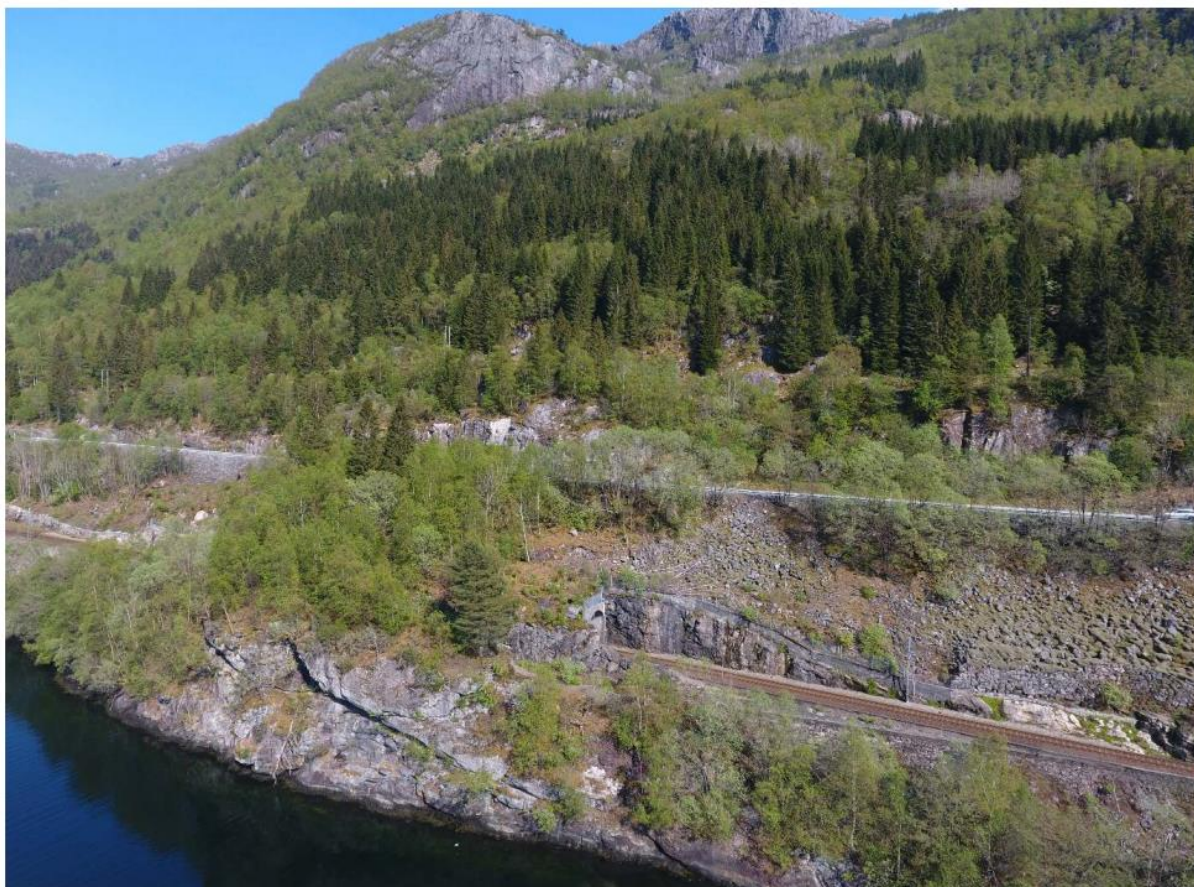
Figur 10 Oversikt over fjellparti der transporttunnel til Linnebakkane vil kome ut. Foto: Øystein S. Lohne, Sweco
