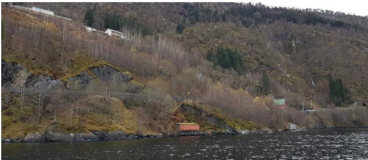
Figur 18 Langhelleneset. Transporttunnel til kaianlegg vil kome ut under dagens E16. Foto Øystein S. Lohne, Sweco
