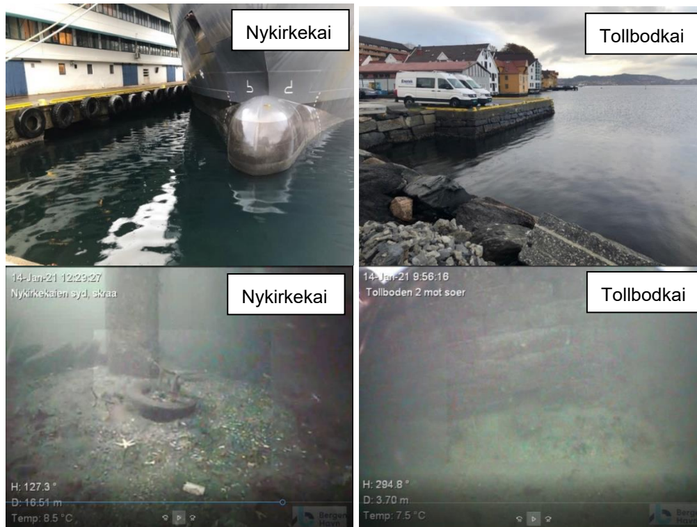
Figur 9 Nykirkekai står på peler (venstre) mens Tollbodkai har murt front (høyre) (kilde: ROV-undersøkelse utført av Bergen Havn, januar 2021).
