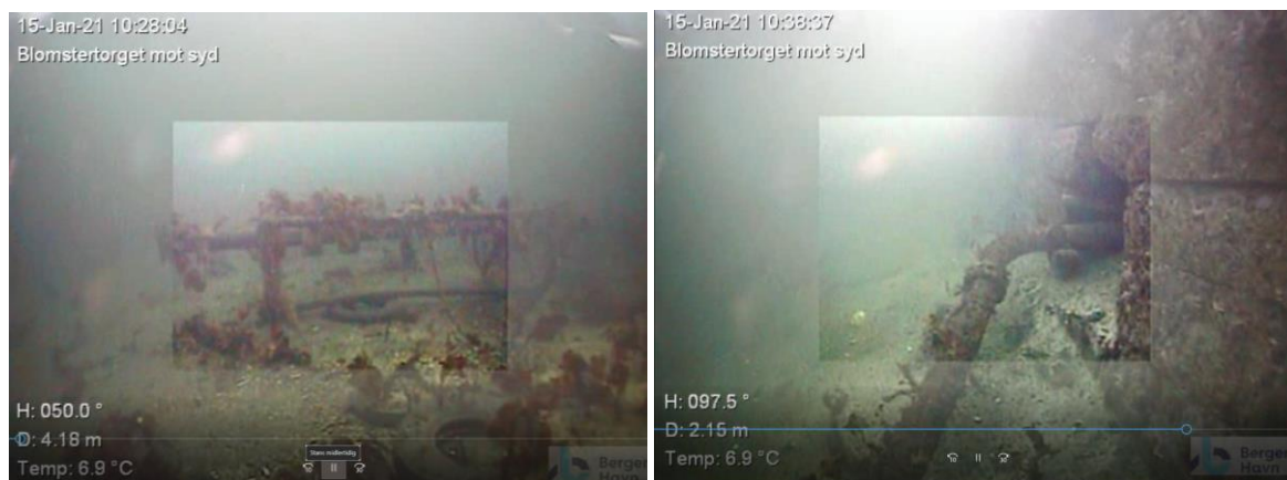
Figur 44 Ledning langs Torget som ikke er inntegnet i VA-etatens datasett. Ledningen er inntegnet med stiplet grønn linje i Figur 43 (kilde: ROV-undersøkelse utført av Bergen Havnevesen, januar 2021).
