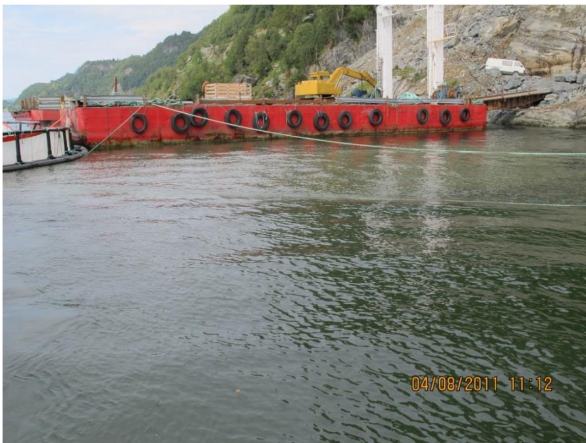
Figur 11. Lekter for dumping av sprengstein. Her frå RV 57, Dalsfjorden i 2011. Då med siltgardin montert utanfor lekteren for å hindre spreining i overflata. Foto: NIVA.
