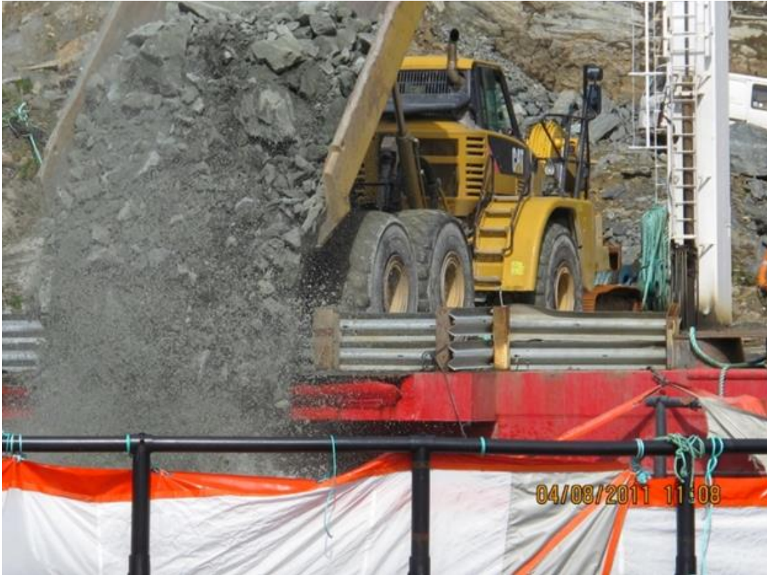
Figur 12- Dumping av sprengstein i Dalsfjorden. Ei siltgardin innesluttar sjølve dumpeområdet ved lekteren.
