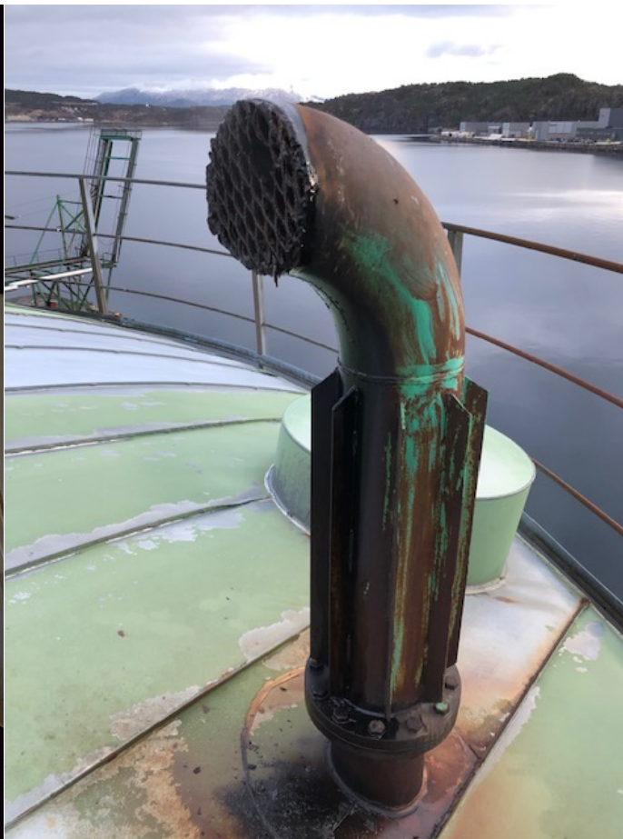
Figur 4. Luftventil depottank T1.
