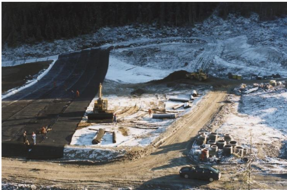
Figur 3: Legging av gummimembran på trinn 1 på deponiet
