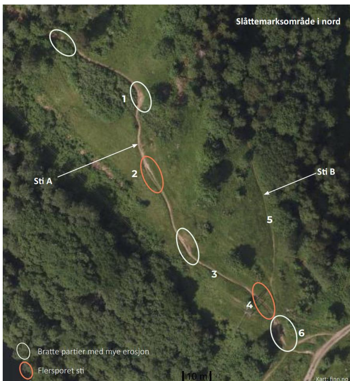
Figur 40. Flyfoto av det nordligste plantefredningsområdet ved Blankvannsbråten viser hvor tydelig slitasjen på slåttemarken er på grunn av sykling (Pir II, udatert).
