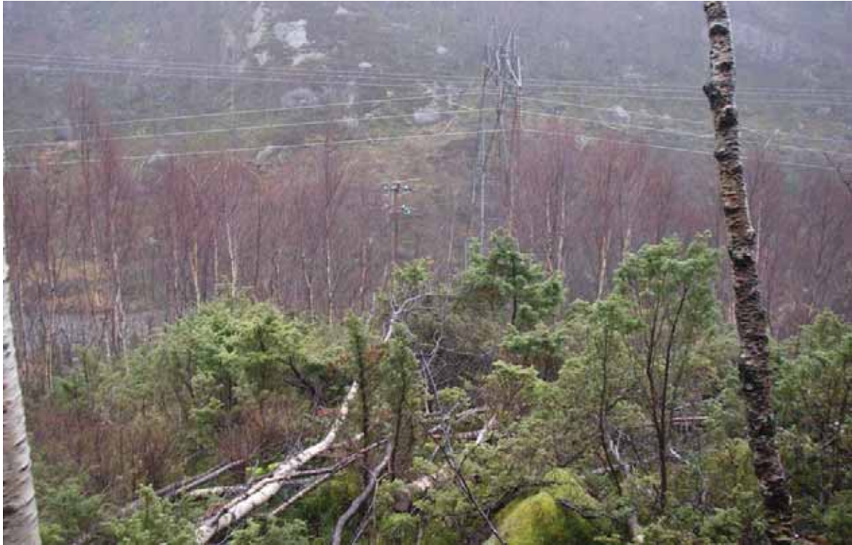
Området i Daladalen der rørgata til Nordåna kraftverk blir lagt.
