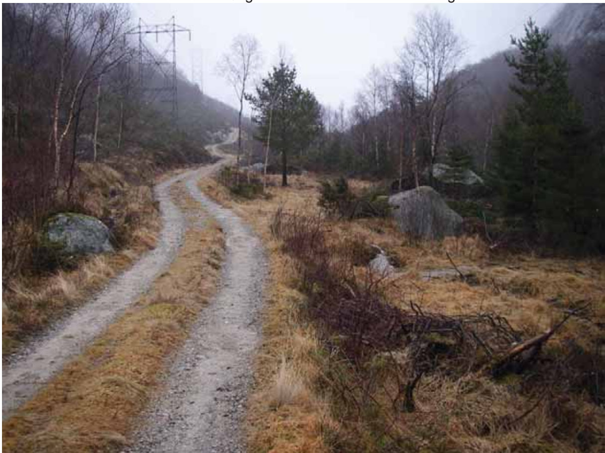
Kraftstasjonsområdet til Nordåna kraftverk, Daladalen.
