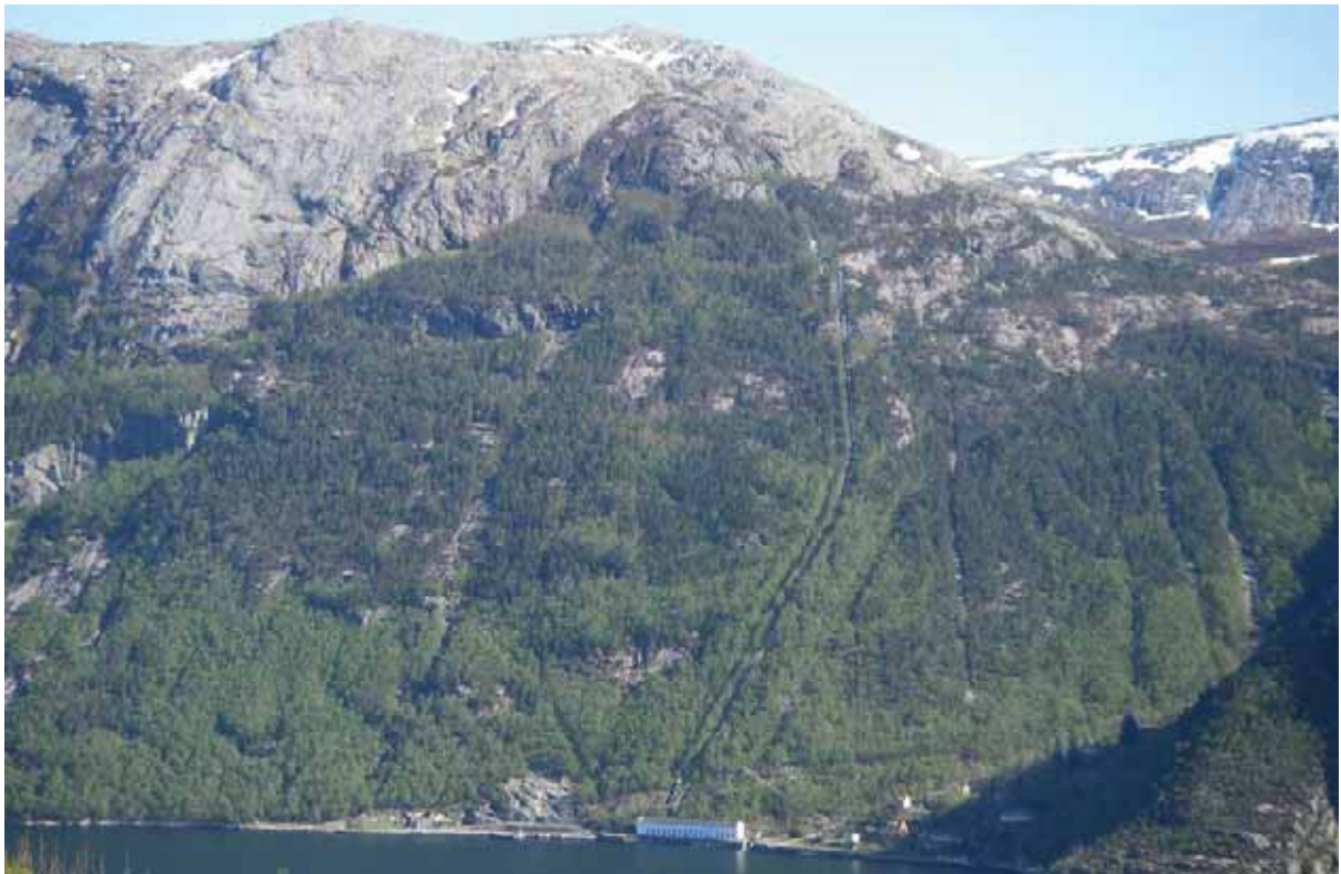
Lysefjorden med Flørli kraftverk
