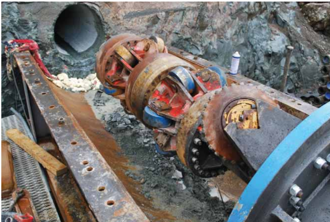
Figur 11. Eksempel på borerigg med underliggende masser fra driving av tunnel.
