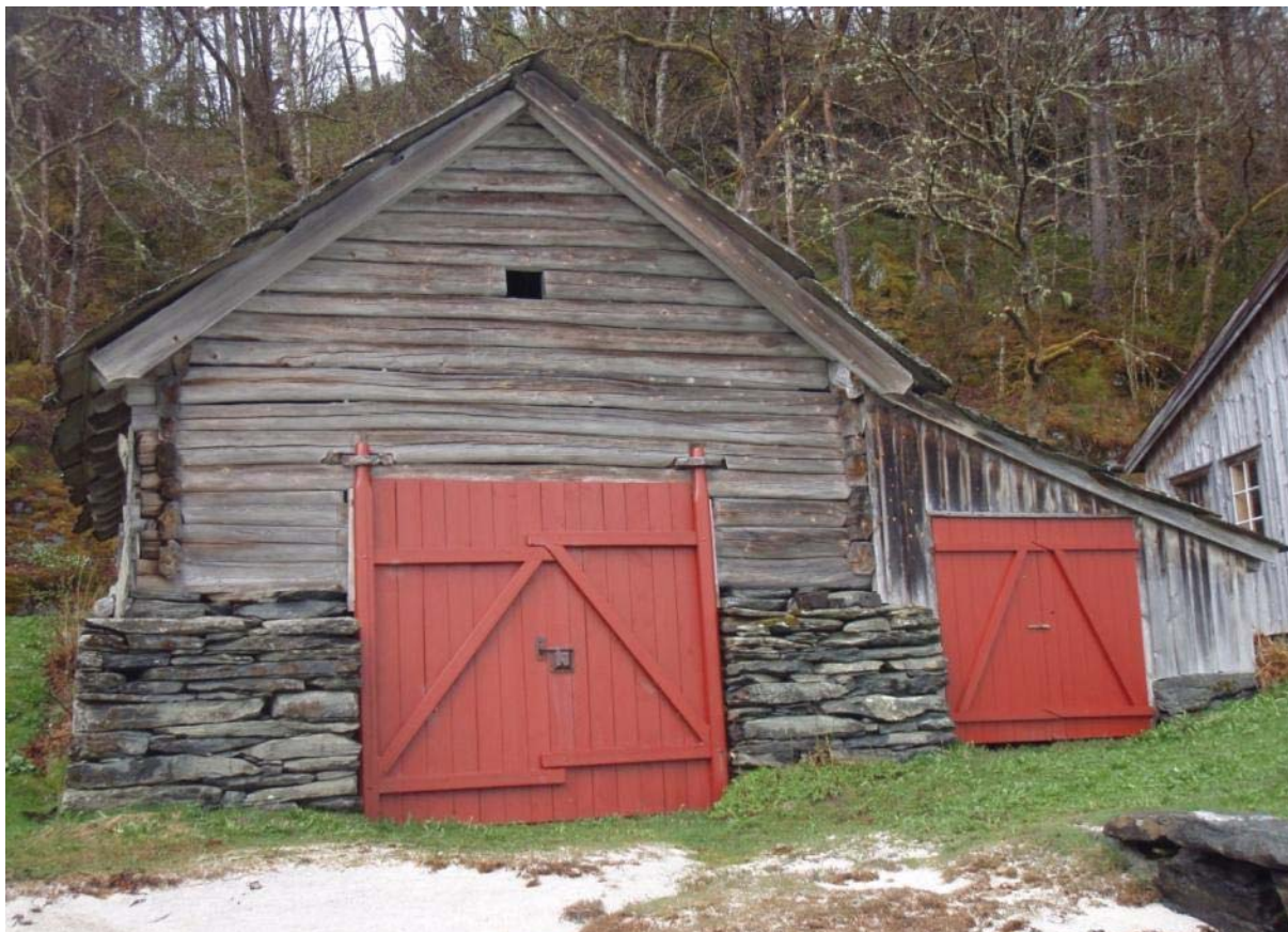
Foto frå naust i tømur og laft. Ved bygging av nye sjøhus og vøle må det nyttast same material som opphavleg og detaljar må kopierast.
