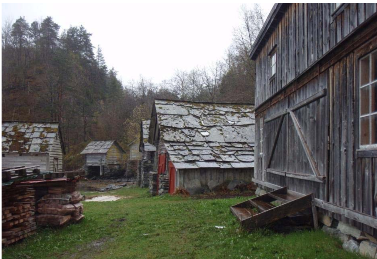
Sjøhusa har helletak og er umåla med naturleg verslitt grånyanse i treverket.
