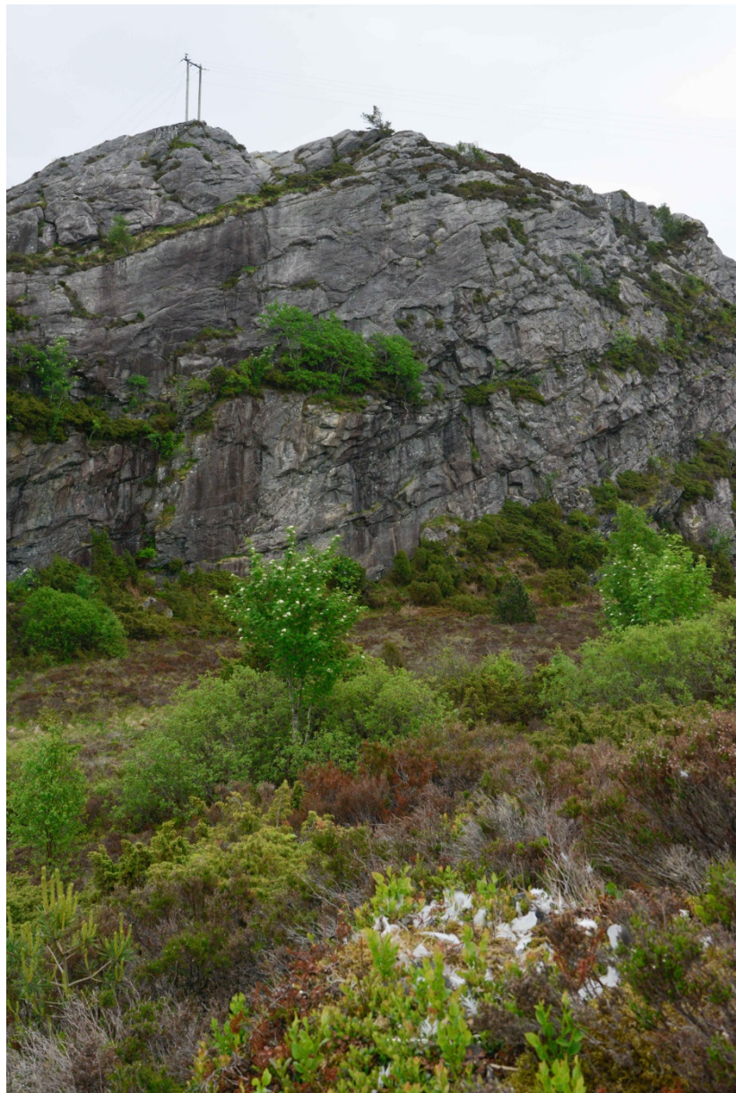
Kraftmast 22kV og hekkeberg for hubro i studieområdet. Ferske byttedyrrestar etter måsefugl viser at hubroen også har tilhald her i år. Foto: M.J.S. ©
